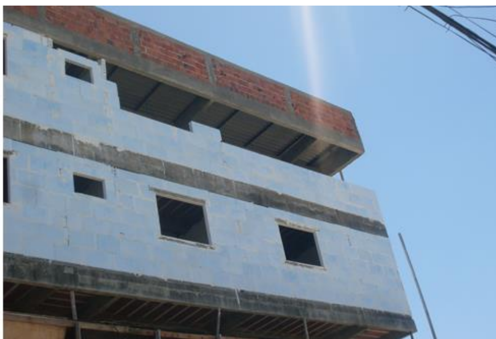
Fig. 2 - Fachadas em blocos de gesso Hidro - Edifício em Petrolina- PE
