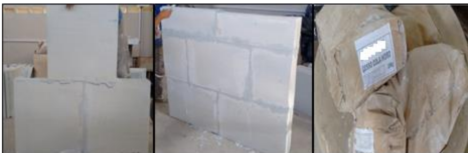
Fig. 32 - Paredes para ensaio de estanquidade e gesso cola hidro para assentamento.
