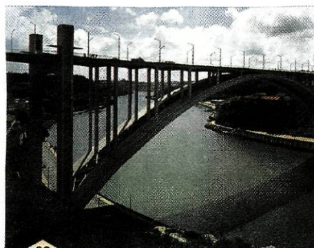
Figura 2- A Ponte de Arrábida, no Porto, construída em betão. Este obtém-se misturando cimento com areia e cascalho
