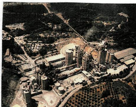
Figura 3- Fábrica de cimento SECIL. O cimento obtém-se em fornos, aquecendo a altas temperaturas certas rochas ricas em calcário e argila ( margas ) ou misturas pulverizadas destas duas rochas
