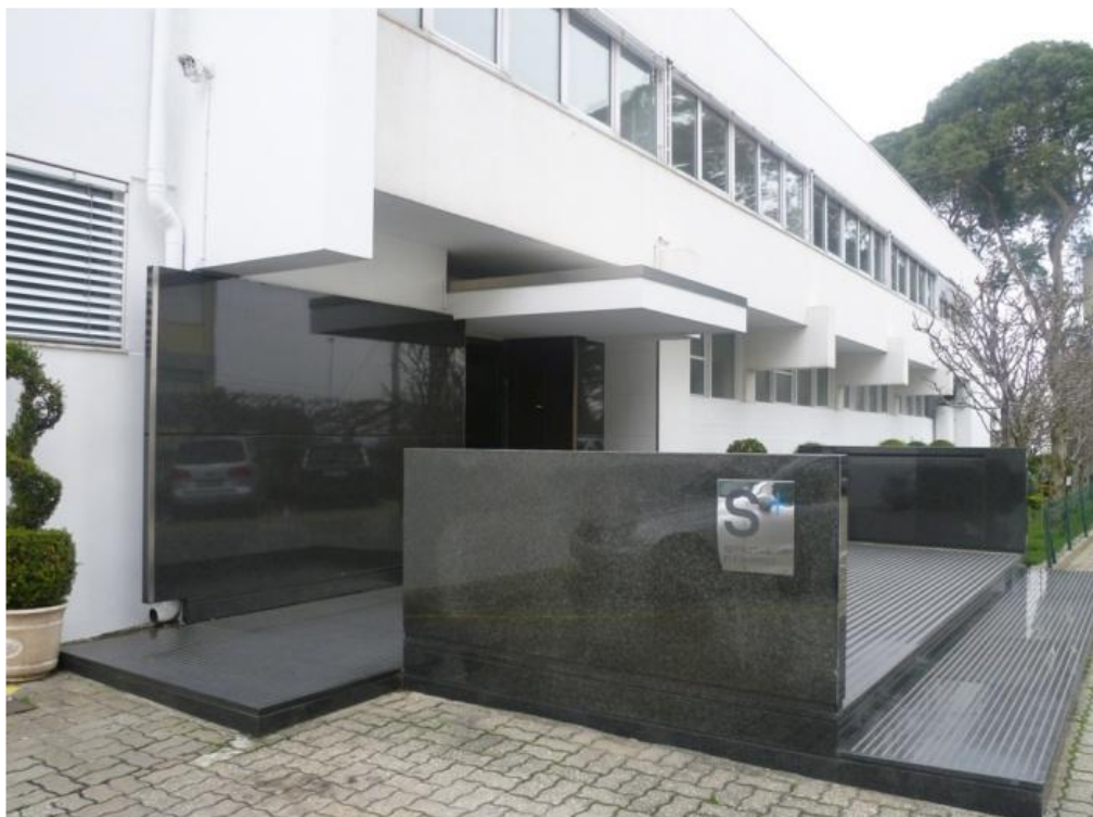
Figura 1- Sede da Schmitt-elevadores
