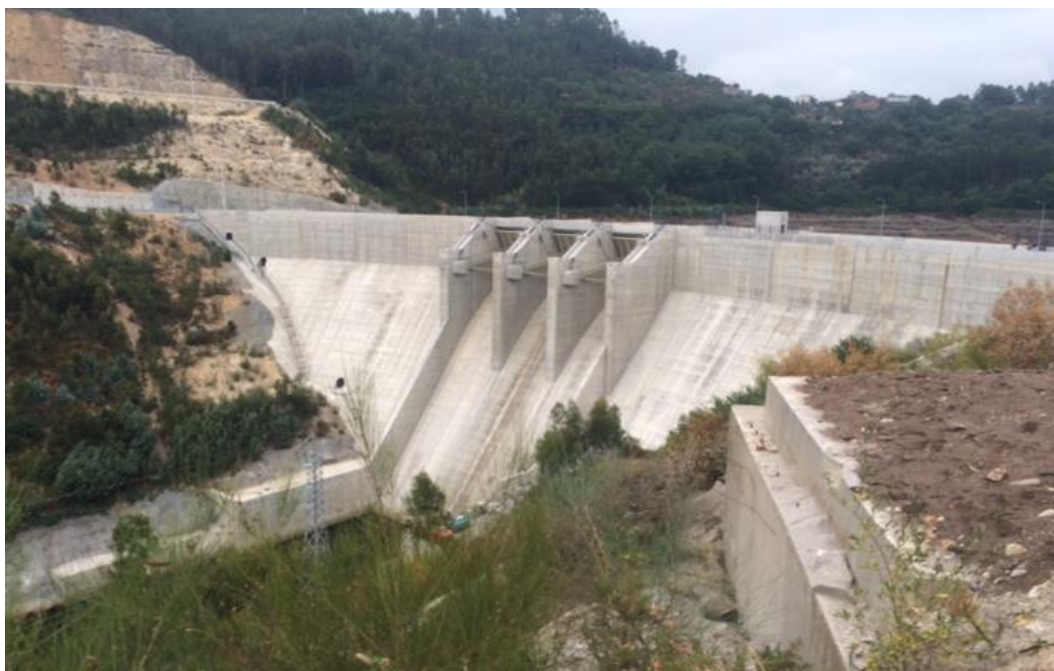
Figura 5 – Barragem de Ribeiradio
