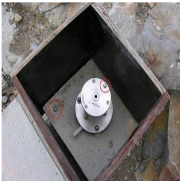
Figura 37 - Exemplo de extensómetro de varas verticais com pontos de referência para fecho de linha de
