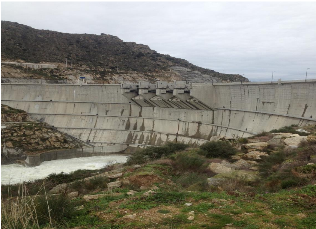
Figura 7 - Barragem do Baixo Sabor (escalão de montante)
