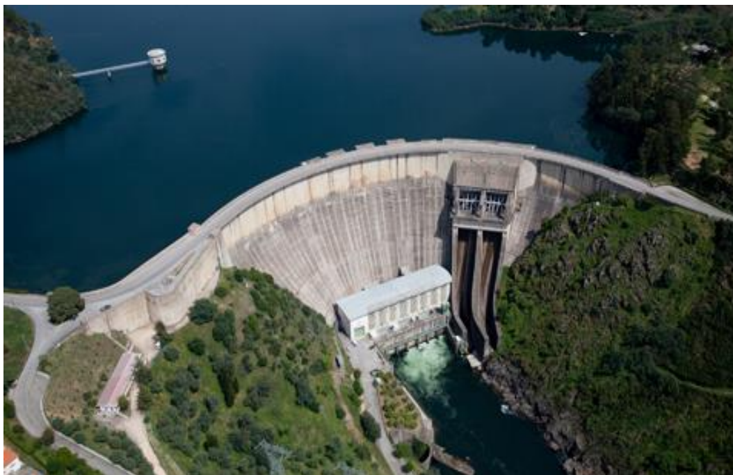
Figura 1 – Barragem de Castelo de Bode
