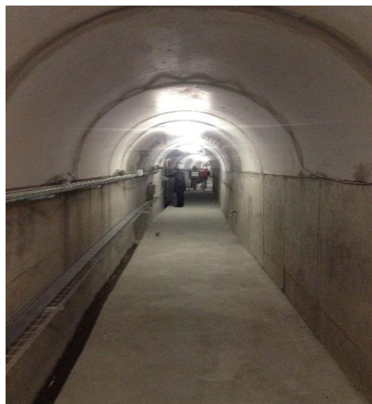
Figura 23 - Exemplo de uma galeria de visita da barragem do Baixo Sabor
