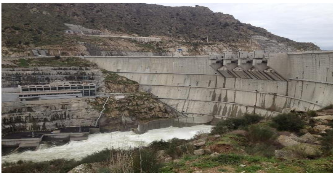
Figura 18 – Barragem do Baixo Sabor (escalão de montante)
