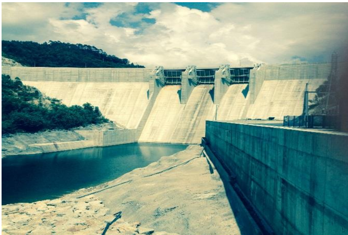
Figura 36 - Barragem de Ribeiradio
