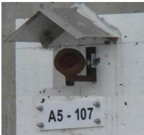
Figura 48 – Prisma GMP104 instalado no paramento
