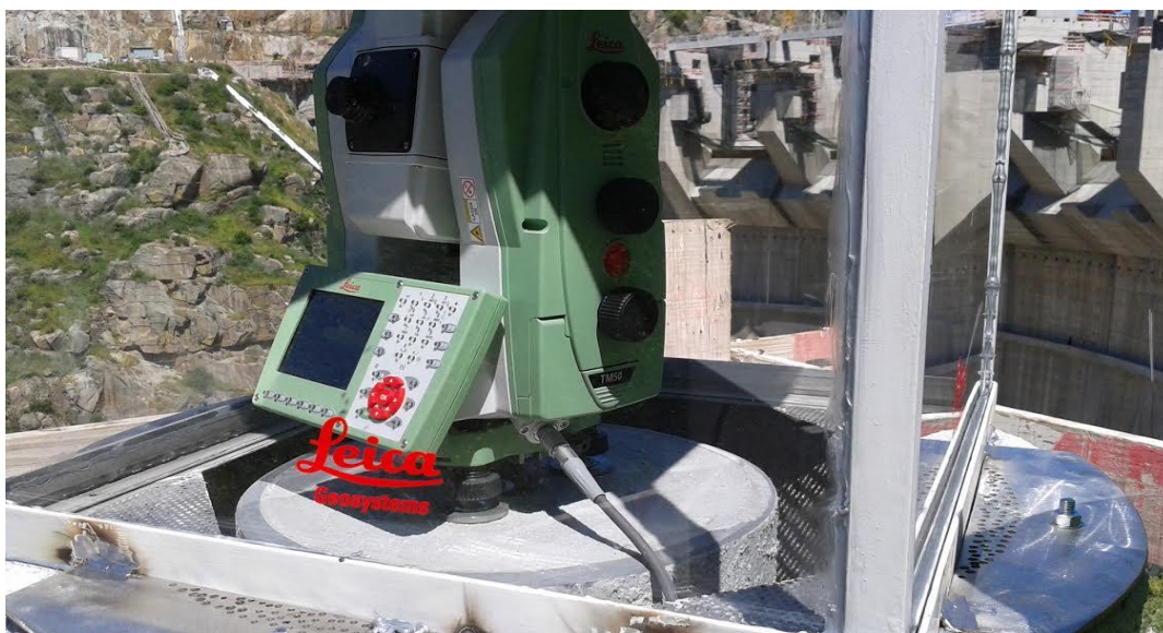
Figura 17 - Estação Total robotizada na barragem de Foz Tua
