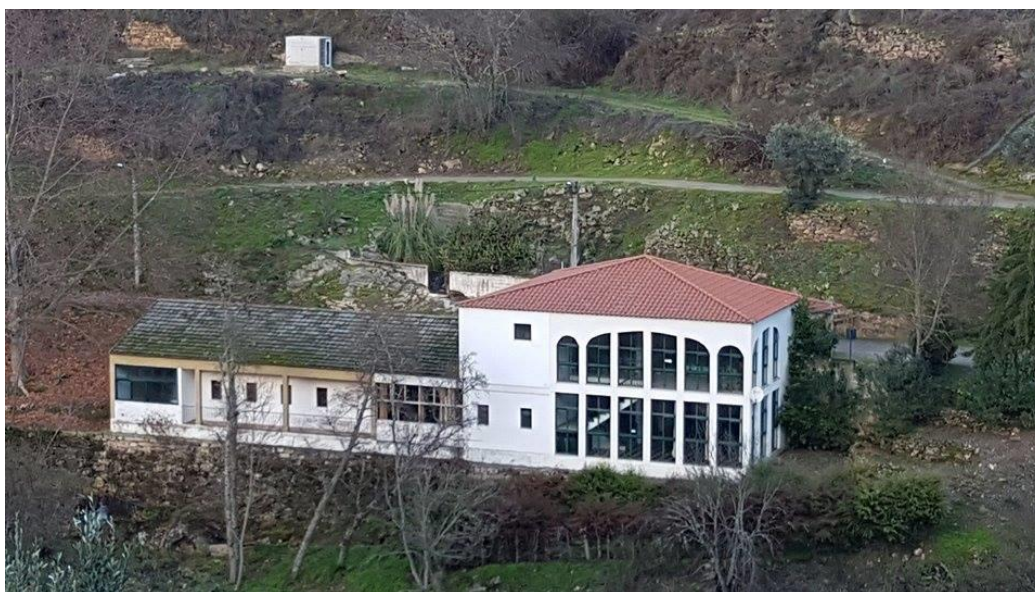
Figura 15. Balneário termal das termas de Caldas de Carlão.
