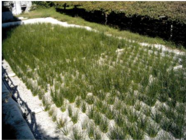
Figura 13 - HFs em série anteriores à construção do pântano reativo.
