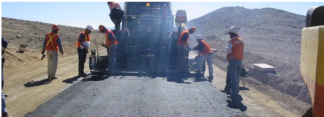
Figura 5 - Aplicação de betume para pavimentação (9).
