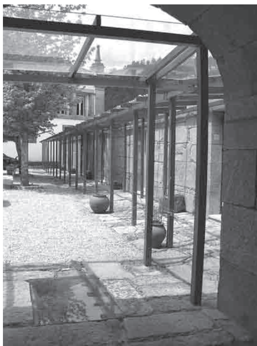
Fig. 11 - Parte da reabilitação contemporânea do Mosteiro de S. Cristóvão de Lafões destinada a albergar parte dos quartos para turismo rural (foto: AMM)
