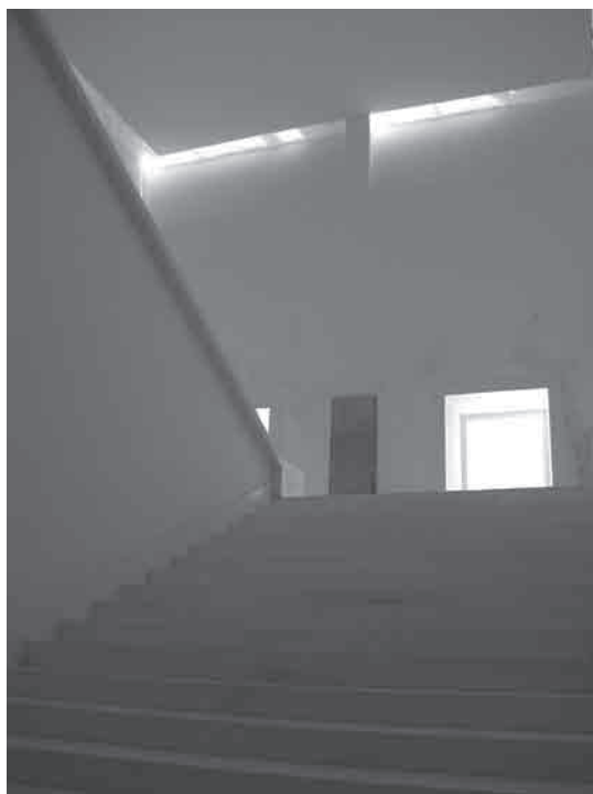
Fig. 16 - Ala S. Bernardo, escada de ligação entre os dois pisos existentes com a introdução de iluminação zenital (foto: AMM)
