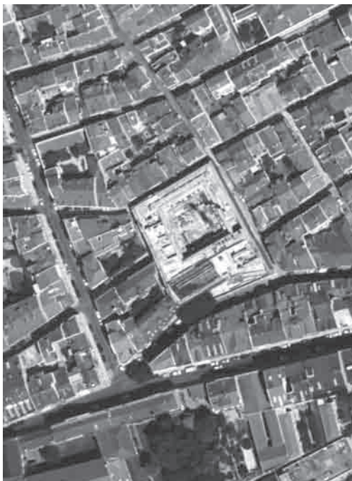
Fig. 7 - Mosteiro de N. Srª de Nazaré do Mocambo (“Convento das Bernardas”) durante as obras de reabilitação. Podem observar-se os limites e inserção do Mosteiro na actual malha urbana de Lisboa (foto: IgeoE)
