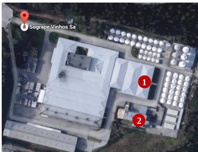
Figura 18 - Instalações Sogrape Avintes
