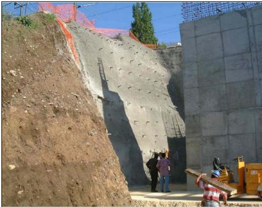
Figura 4 Vertente estabilizada com pregagens. Retirado de: https://www.researchgate.net/publication/282250879_Ancoragens a 20/09/2016
