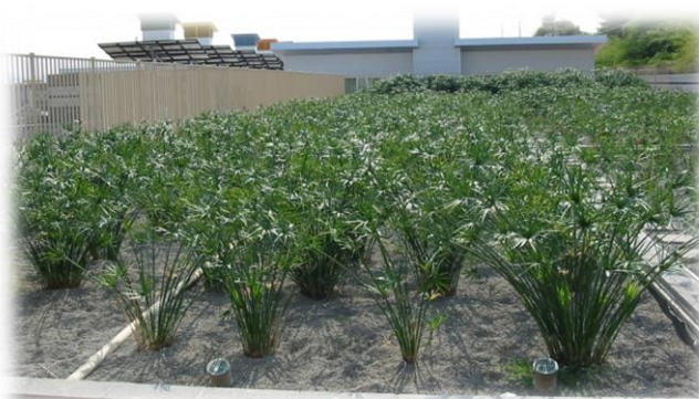
Figura 5 - Exemplo de um Leito de Macrófitas com fluxo subsuperficial. O nível da água encontra-se abaixo do substrato. (Fonte: www.solaripedia.com/images/large/3636.jpg )
