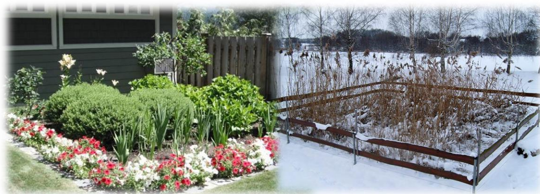
Figura 2 - FitoETAR aplicadas em diferentes circunstâncias: pequena escala para tratamento descentralizado de pequenos volumes de efluentes (à esquerda; fonte: http://wetpac.ca/images/stories/square-vtf-constructed-wetland.jpg ) e em climas frios (à direita; fonte: www.aqua-nostra.de/img/gallery/pflanzenklaeranlage-winter.jpg?1463139191885 ).
