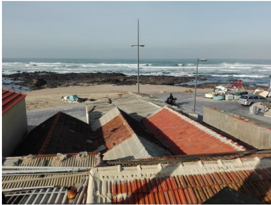
Figura 27 AUGI em zonas costeiras - Rua de Angeiras
