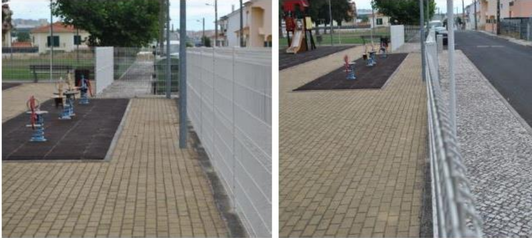
Figura 7 Pavimentos (tartan; pavê; vidraço) Bairro da Junqueira, Loures
