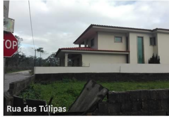
Rua das Túlipas Fig. 20 Moradia
