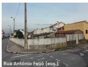
Fig. 1 Habitação em mau estado
