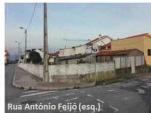
Fig. 1 Habitação em mau estado
