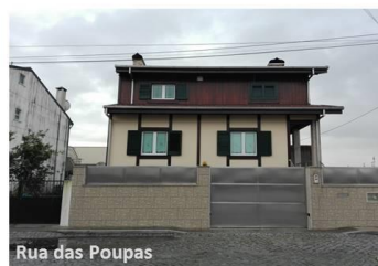
Rua das Poupas Fig. 35 Habitações
