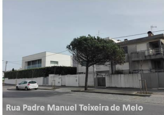
Fig. 10 Habitações em bom estado
