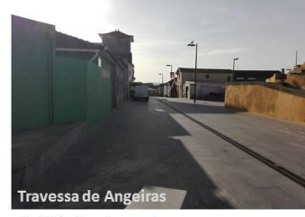
Travessa de Angeiras Fig. 12 Pavimento recente
