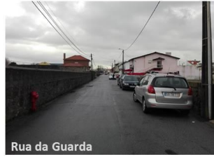
Rua da Guarda Fig. 1 Rua alcatroada sem estacionamento formalizado
