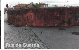
Rua da Guarda Fig. 2 Habitações com área agrícola
