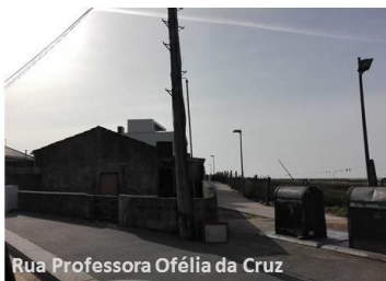
Fig. 7 Habitação antiga em estado de abandono
