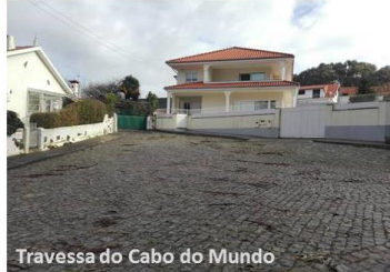
Fig. 11 Praça entre as habitações
