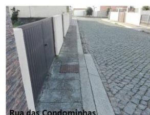
Fig. 5 Passeio pequeno em bom estado
