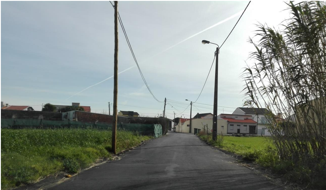
Figura 71 Fotografia actual - Rua de Antevila
