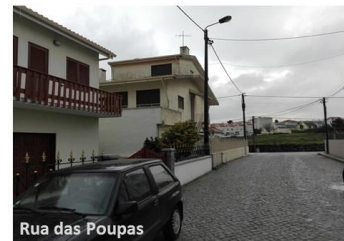
Rua das Poupas Fig. 36 Rua sem estacionamento formalizado
