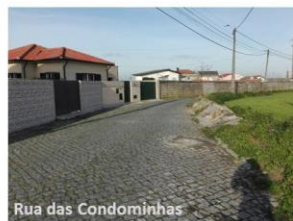
Fig. 1 Rua de circulação automóvel
