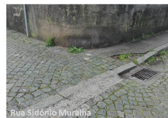
Rua Sidónio Muralha Fig. 36 Transição do pavimento e passeio
