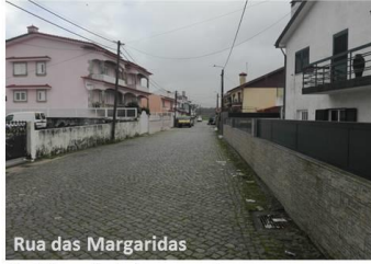
Rua das Margaridas Fig. 7 Rua principal sem passeio
