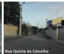
Fig. 6 Rua sem passeio
