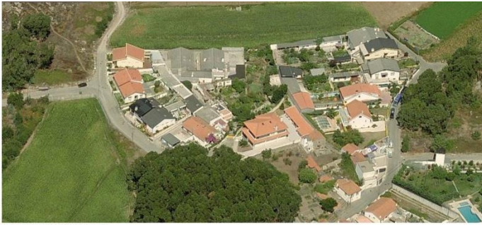
Fotografia aérea com vista panorâmica
