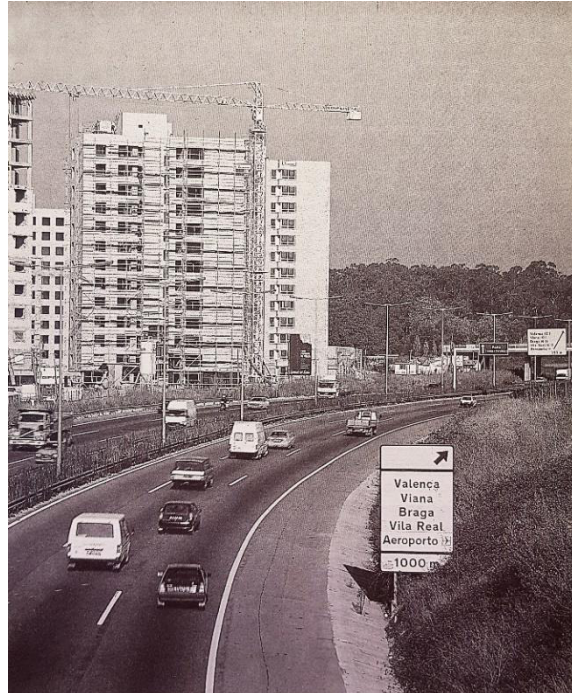
Fig. 11 - Vista para a CCP, com pormenor da Via de Cintura Interna (VCI), quando esta ainda era considerada uma estrada nacional (Fonte: Martins, 1992-93)
