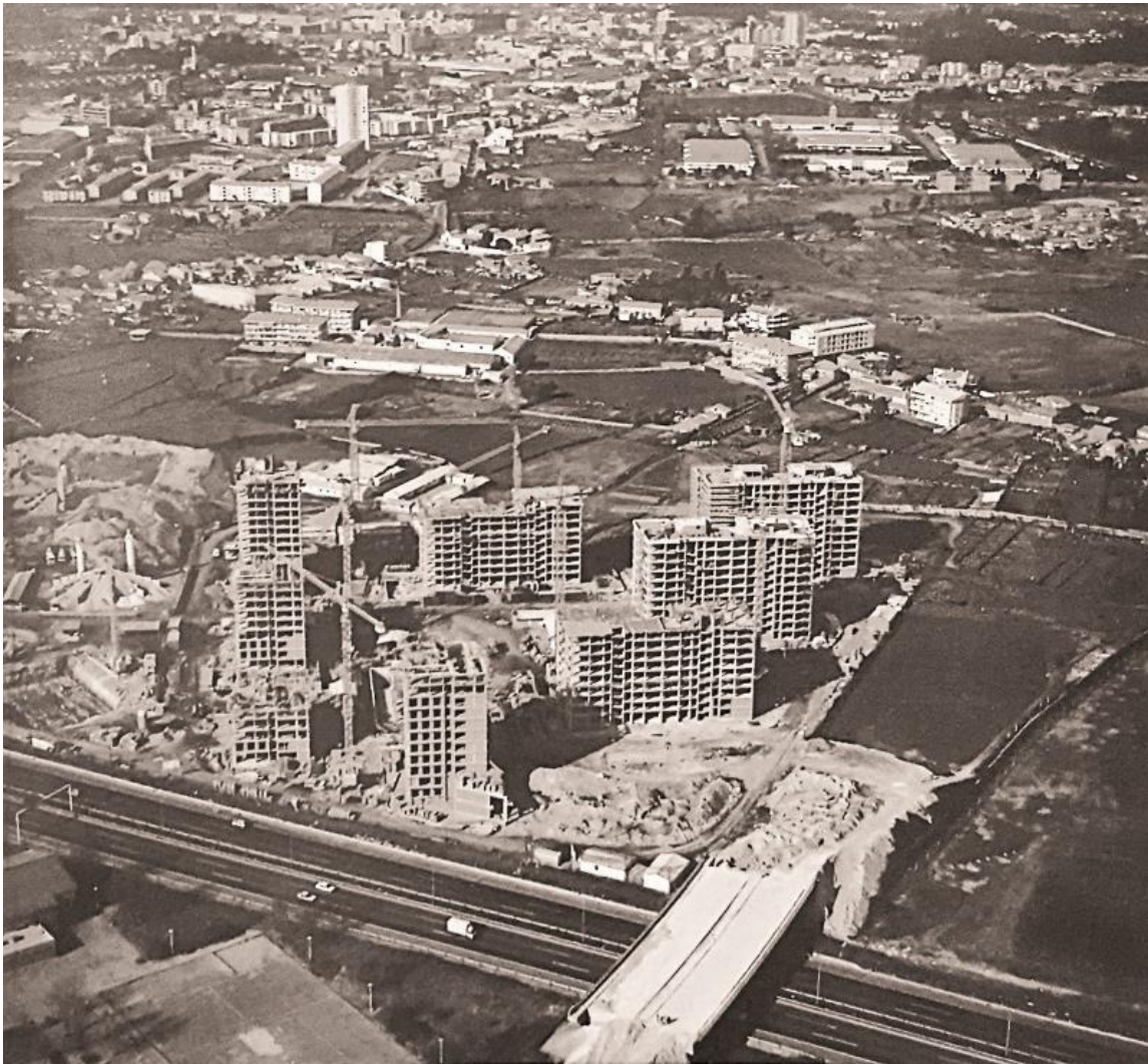
Fig. 10 - Vista aérea sobre a construção da CCP (Fonte: Cidade Cooperativa da Prelada, 1991-92)
