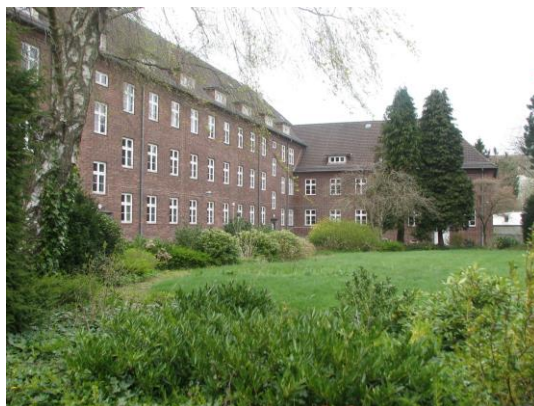
Fig. 11 - Vista norte do edifício da Bundeswehr. Fonte: RMP.
