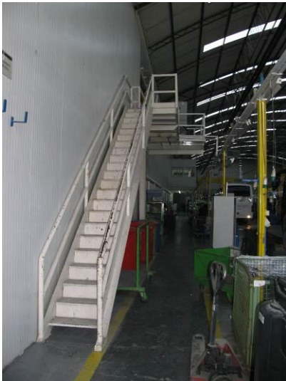
Figura 21 – Escadas de acesso à plataforma.
