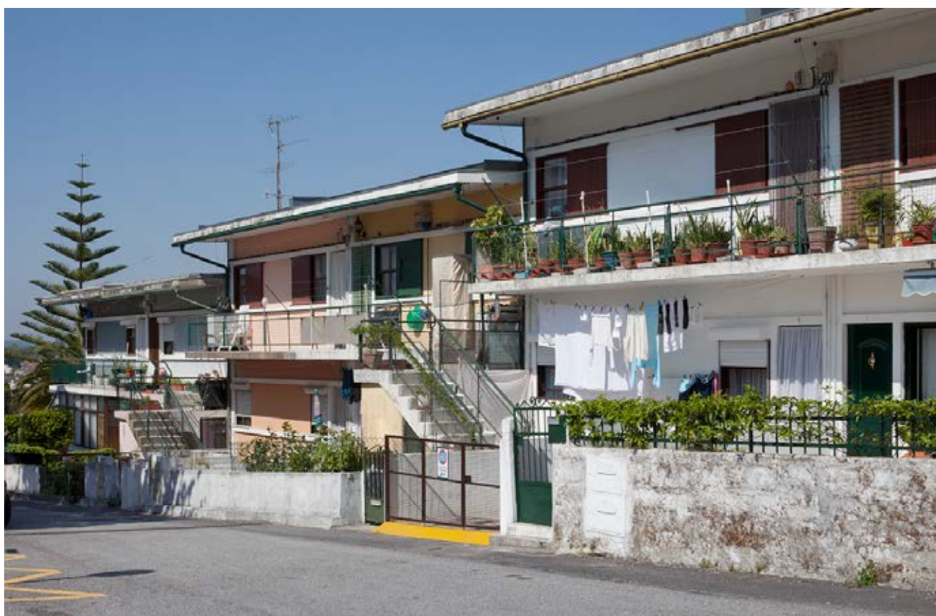
Figura 27. Vista dos fogos tipo simplex (Sul-Norte) © Tiago Casanova
