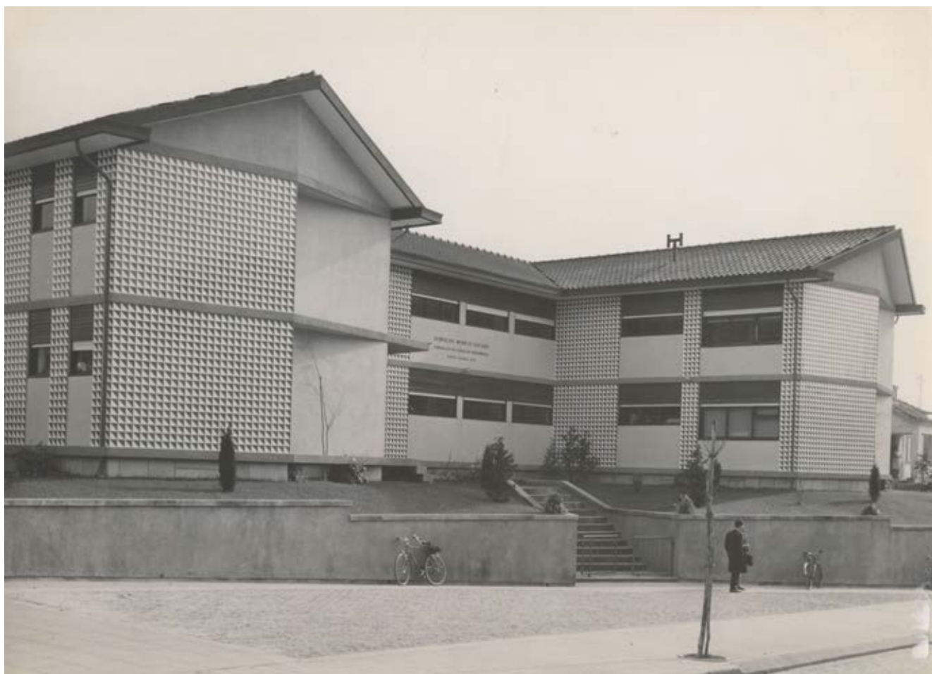
Figura 77. Vista geral do edifício aquando da sua construção
