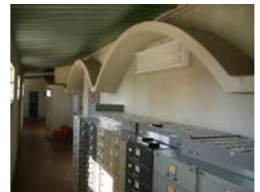
Figura 20. Vista do interior do piso recuado, zona de lavandarias Estado actual
