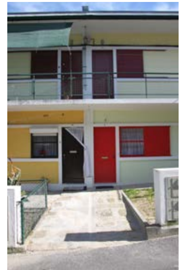
Figura 28. Pormenor dos vãos e cores nos fogos tipo © Tiago Casanova
