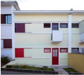
Figura 24. 1951, Bairro da Caixa Têxtil, Arquitecto Germano de Castro Pinheiro, @Tiago Casanova
