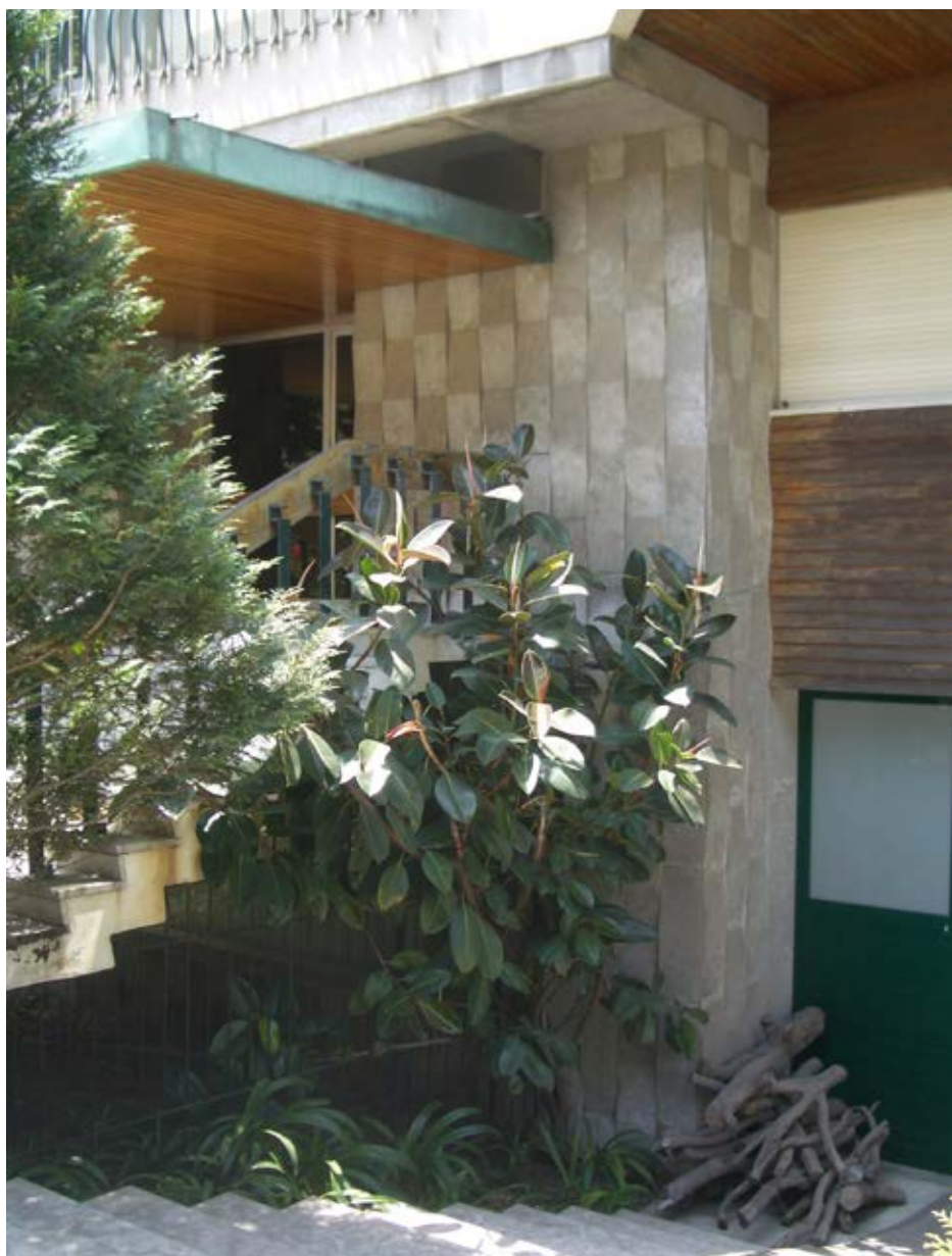
Figura 110. Vista aproximada sobre a entrada
