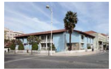
Figura 26. 1955, Posto Médico de Negrelos, Arquitecto Germano de Castro Pinheiro
