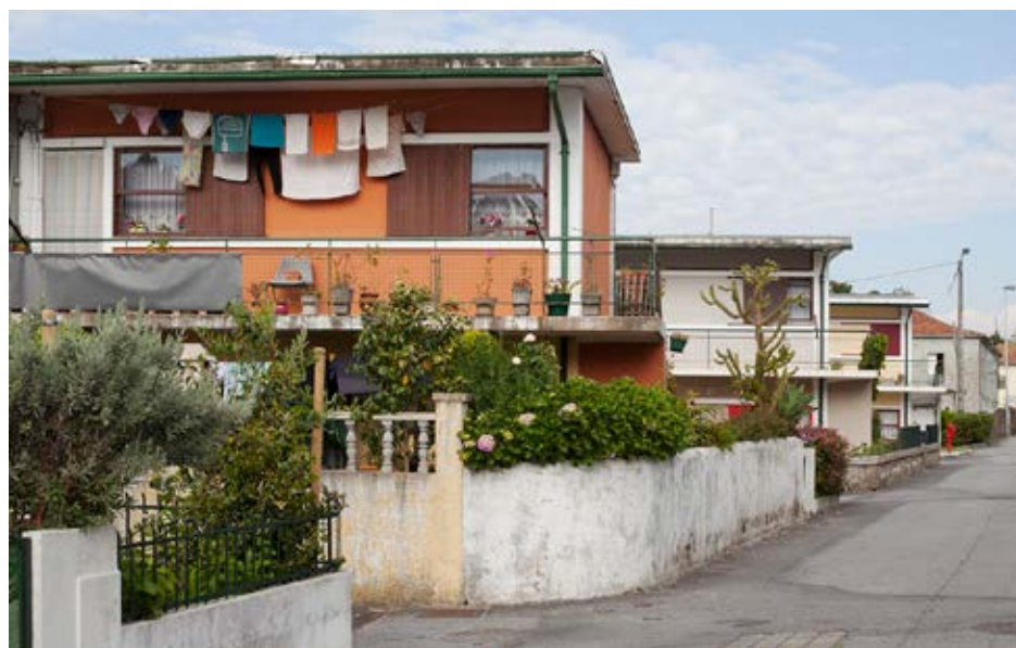
Figura 32. Vista da rua principal, topo dos fogos tipo simplex (Poente-Nascente) © Tiago Casanova
