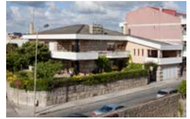
Figura 103. Vista elevada do conjunto Pinheiro Arquitectos © Tiago Casanova
