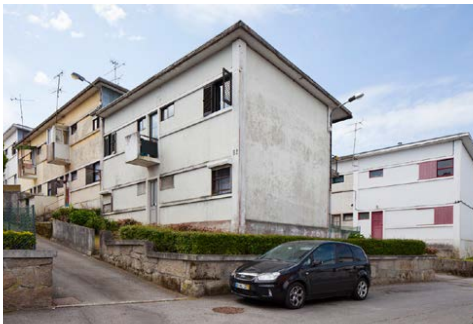
Figura 34. Vista da rua principal, topo dos fogos duplex (Nascente-Poente) © Tiago Casanova
