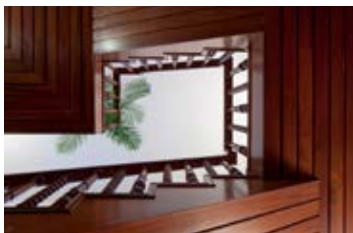
Figura 107. Vista sobre varandas e entrada © Tiago Casanova
