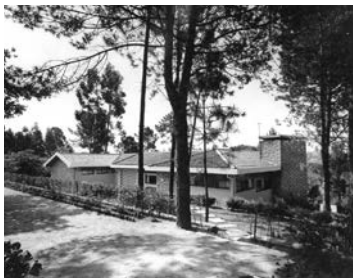
Figura 59. Vista da casa a Norte Arquivo escritório Germano de Castro Pinheiro Arquitectos
