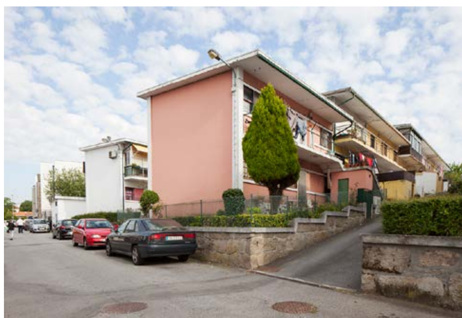
Figura 36. Vista da rua principal, topo dos fogos duplex (Poente-Nascente) © Tiago Casanova
