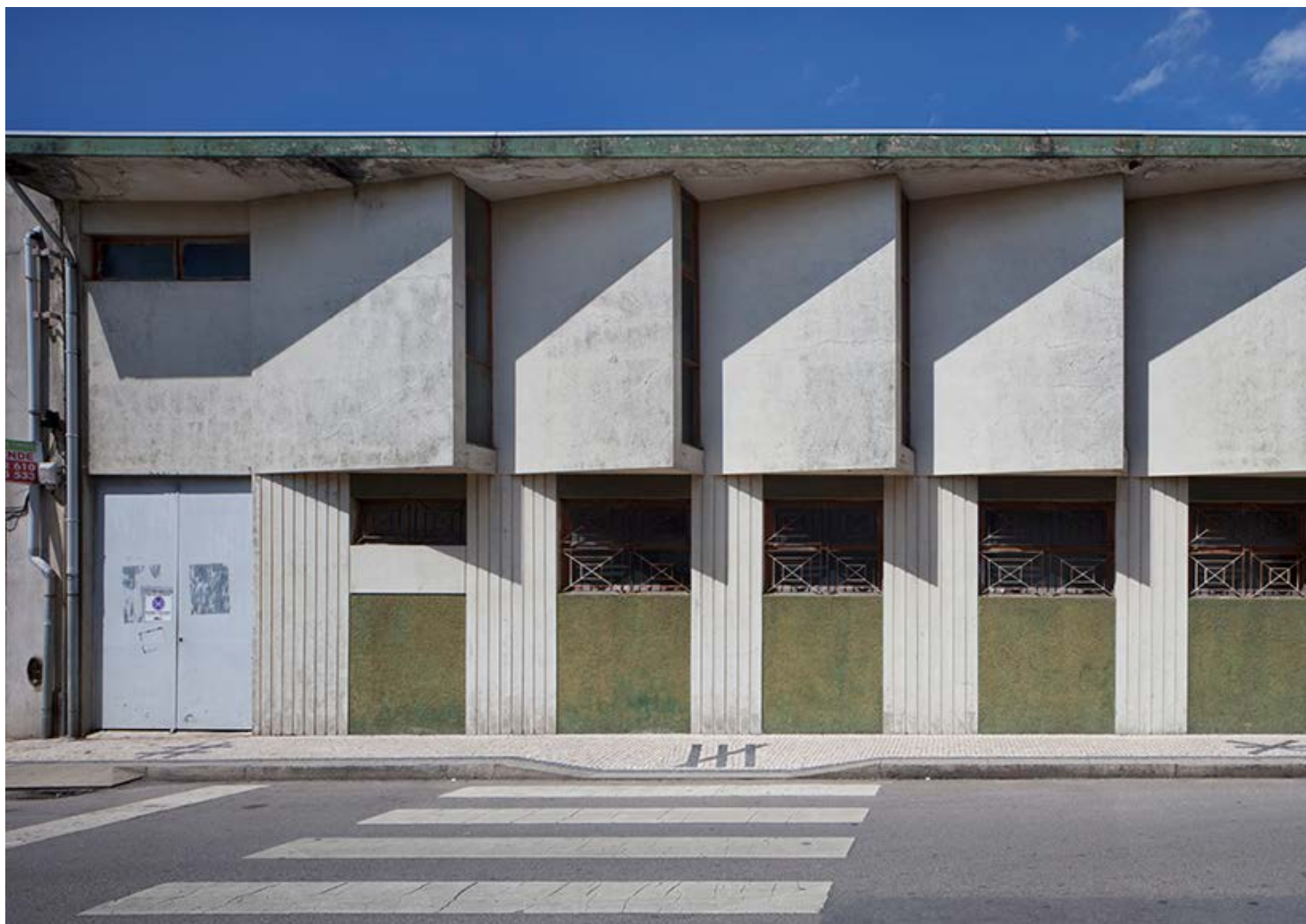
Figura 65. Vista frontal, alçado Sul © Tiago Casanova
