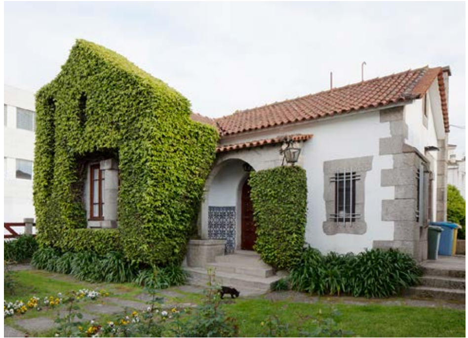
Figura 10. Vista sobre entrada principal © Tiago Casanova
