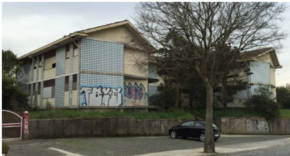
Figura 78. Vista geral do edifício actualmente abandonado
