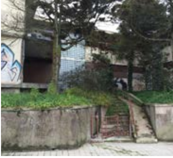
Figura 79. Vista sobre acesso de entrada
