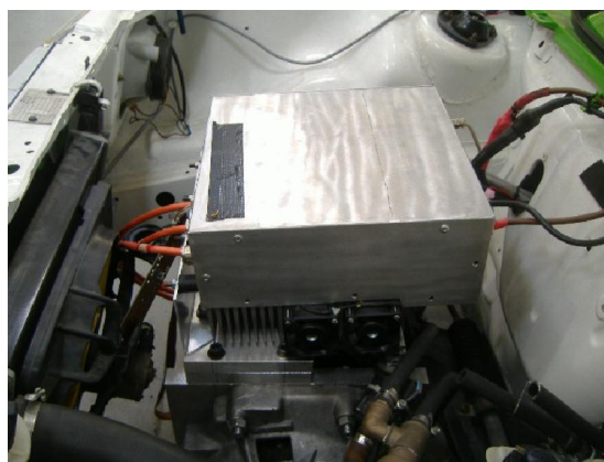
Figura 68 – Montagem do controlador
