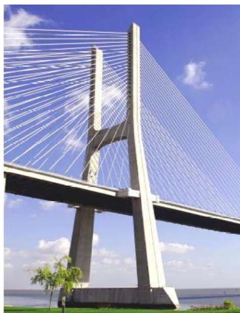
Fig. 2. 7 - Ponte Vasco da Gama. Inclinação dos fustes na direção do tabuleiro (Pedro 2010).
