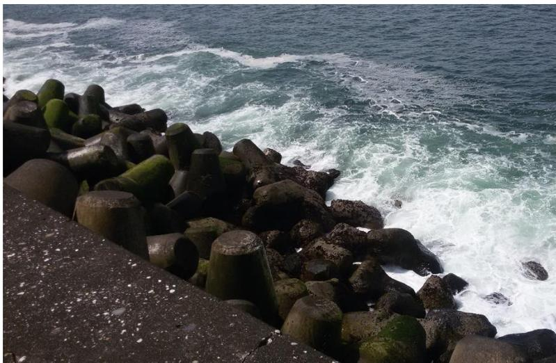
Figura 41 - Tetrápodes colocados no quebramar norte do Porto de Leixões.
