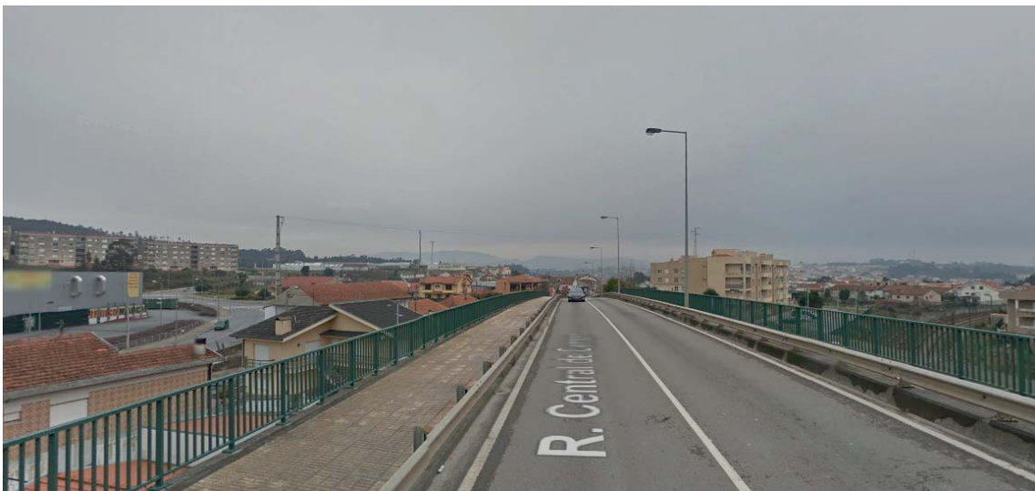
14. EN 15, Viaduto sobre caminho-de-ferro, Campo
