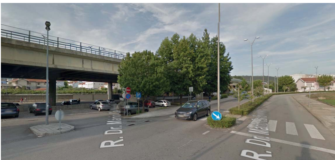
29. Viaduto da A4 e caminho-de-ferro entre Valongo e Suzão
