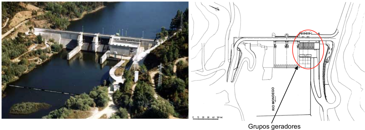
Fig. 5.20 – Barragem da Raiva. Planta. Adaptado de (cnpqb.apambiente.pt).
