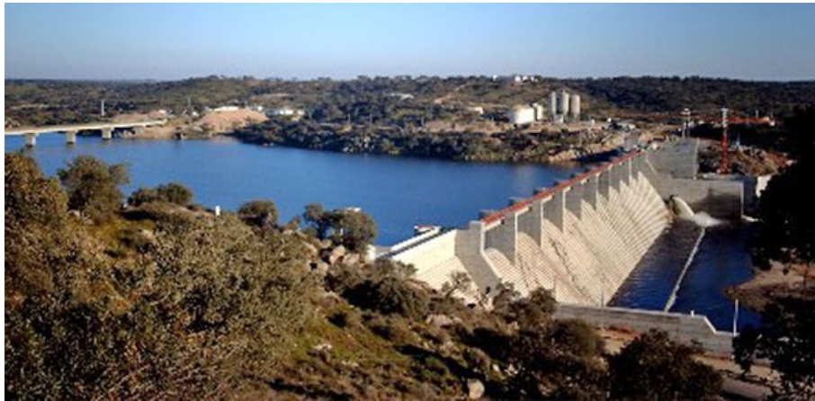
Fig. 5.29– Barragem de Pedrógão. Vista da margem direita. ( cnpqg.apambiente.pt ).
