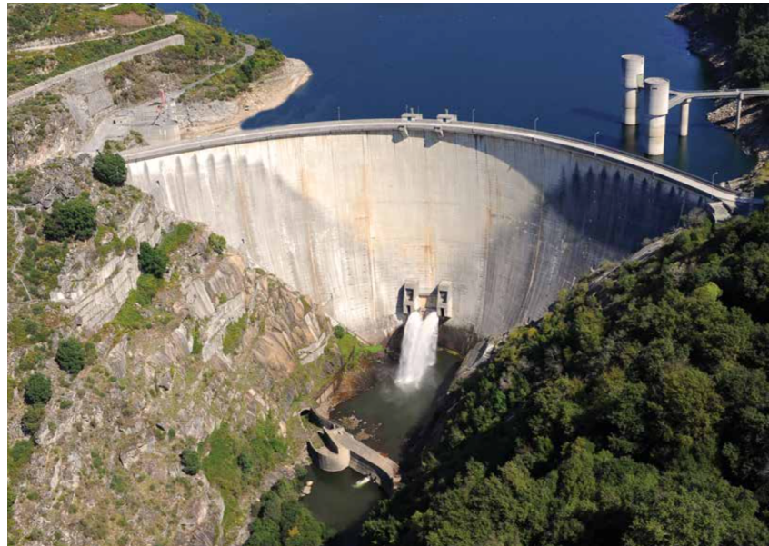
Fig. 5.4 – Barragem do Alto Lindoso com dispositivo de caudal ecológico em funcionamento. ( http://visao.sapo.pt/ ).
