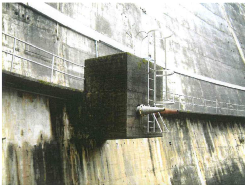
Fig. 5.12 – Barragem de Vilarinho das Furnas. Dispositivo de caudal ambiental. (Ferreira, A. 2010).
