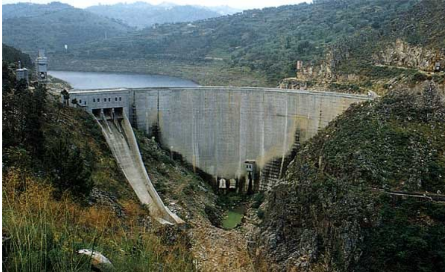
Fig. 6.15 – Barragem de Varosa. (cnpqb.apambiente.pt).
