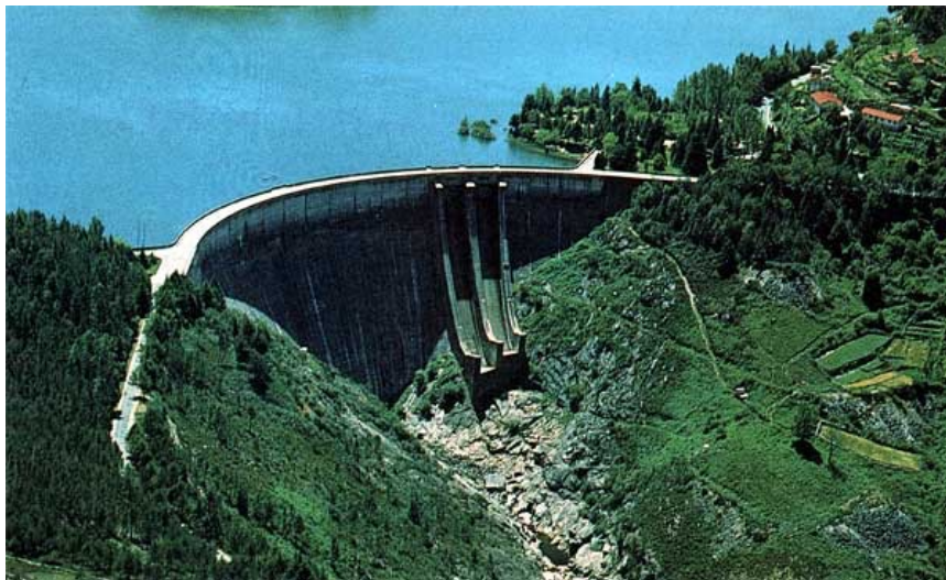
Fig. 6.7 – Barragem de Venda Nova. ( cnpqgb.apambiente.pt ).
