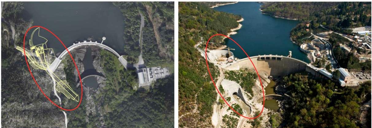
Fig. 5.22 – Barragem de Salamonde. Novo descarregador de cheias.
