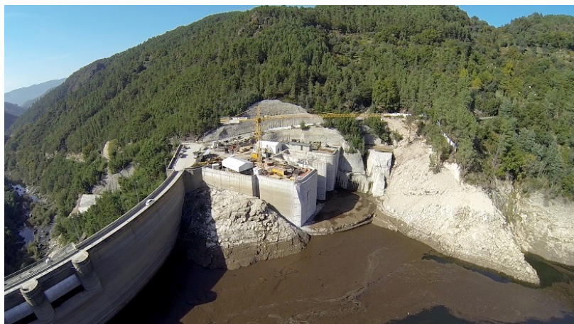
Fig. 5.23 – Barragem de Salamonde com obras em curso no novo descarregador.
