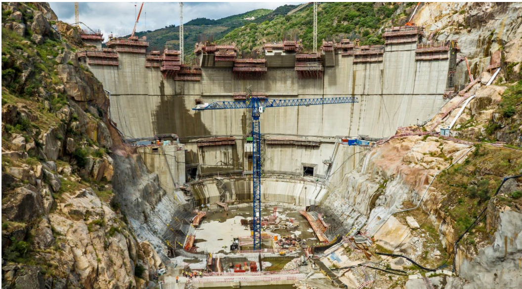
Fig. 5.33 – Barragem de Foz Tua, em construção. Vista de jusante.
