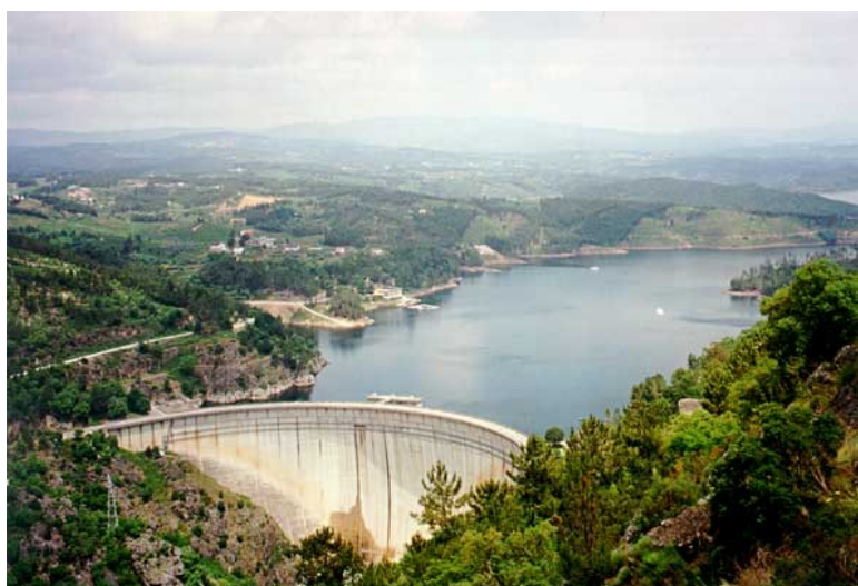
Fig. 2.4 – Barragem de Cabril (cnpq.inag.pt)
