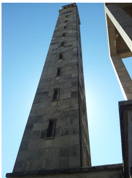
Fig. 6.33 – Vista pormenorizada da torre com orientação NO-SE
