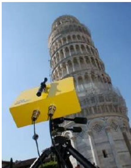
Fig. 4.1 – IBIS-FS, monitorização torre de Pisa[75]
