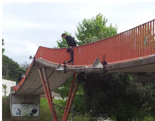
Fig. 6.47 - Colocação dos cones refletivos
