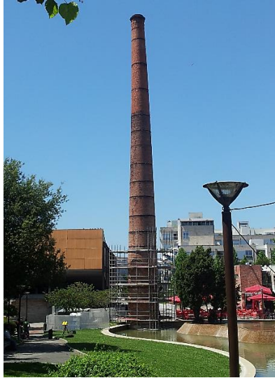
Fig. 6.19 - Chaminé de alvenaria de tijolo
