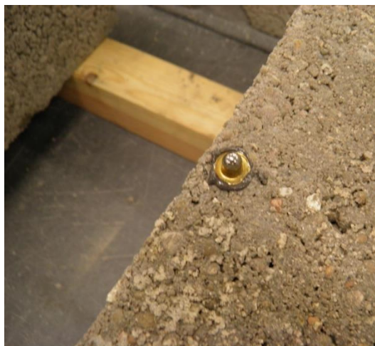
Fig. 3.20 - Pormenor de colagem de fixação com metal liquido
