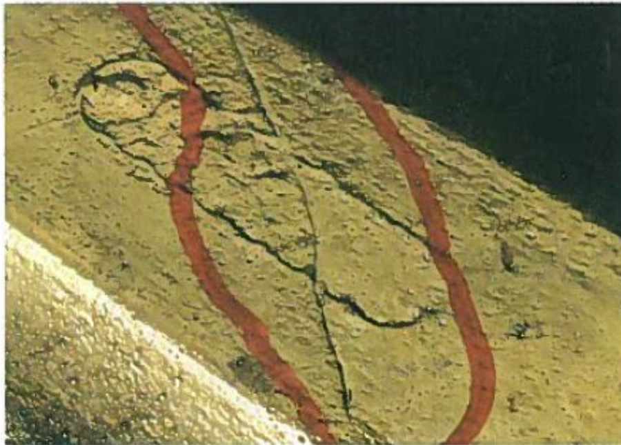
Figura 2.4: Peça mal ligada [Fernando Portela de Castro (1996)]
