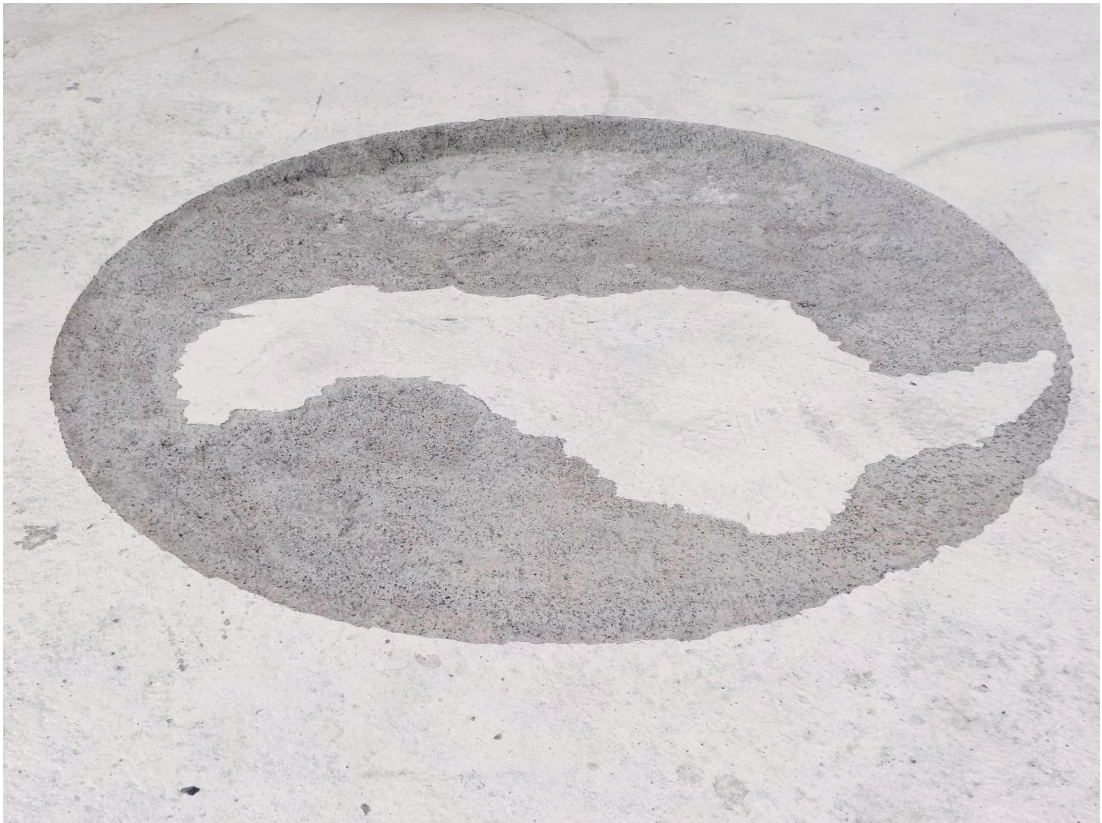
Fig. 23. Vista parcial, escavação em cimento, Ø 90 cm.
