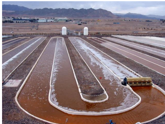
Fig. 2 Imagem ilustrativa de um sistema do tipo raceway homogeneizado por uma roda de pás.
