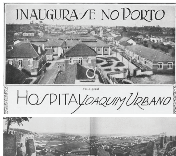
Fig. 102: Hospital de Joaquim Urbano: inauguração das novas instalações e a vista a partir do topo poente do seu terreno (1920).
