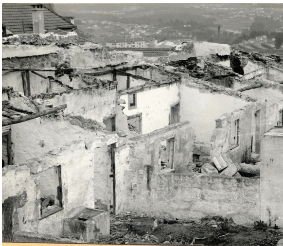
Fig. 101: Ilhas das Eirinhas : trabalhos de demolição (1961). Ao fundo, à esquerda, uma casa do bairro da PSP.
