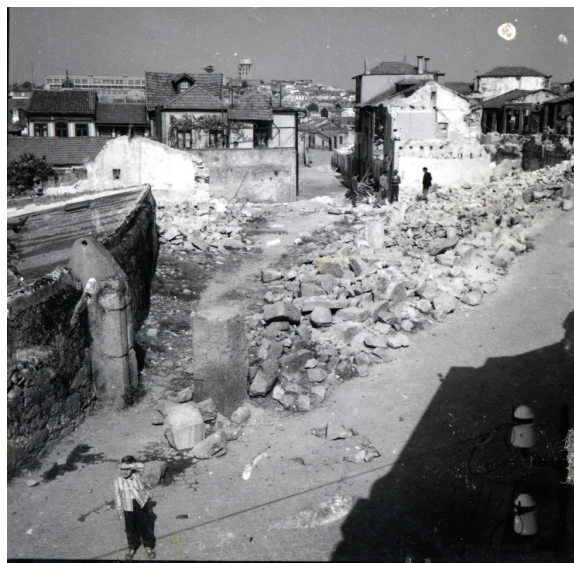
Fig. 100: Ilhas das Eirinhas : trabalhos de demolição (1961).
