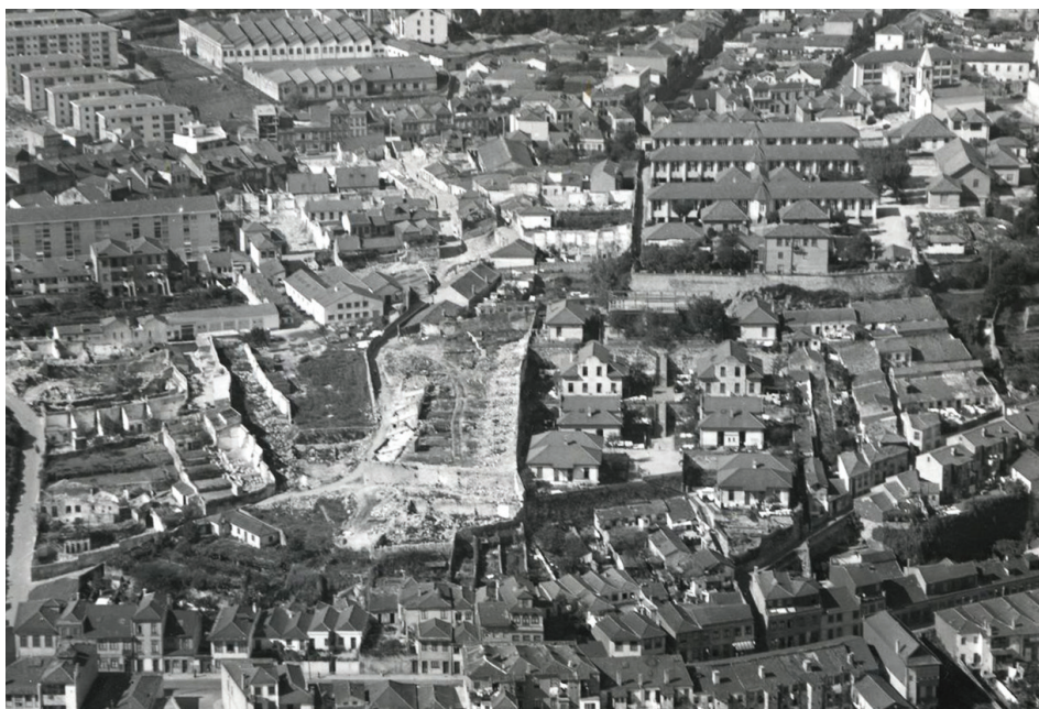
Fig. 103: Eirinhas : vista aérea. São visíveis as casas e a escola do bairro da PSP, o Hospital de Joaquim Urbano acima e o descampado resultante da demolição das ilhas . Ao fundo, à esquerda, distingue-se a Fábrica de Curtumes Gaspar R. Cardoso & C a . e os blocos do recém-construído bairro de Fernão de Magalhães (1961).
