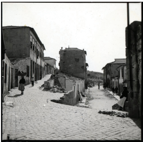
Fig. 99: Ilhas das Eirinhas : trabalhos de demolição (1961).
