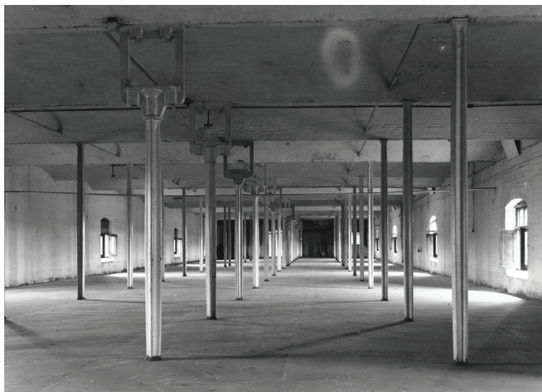
Fig. 22: : Ditherington: interior do Flax Mill , em que é visível a estrutura de ferro no suporte das abóbadas de tijolo. W. Strutt já teria experimentado esta solução no seu cotton mill , no suporte de vigas em madeira.
