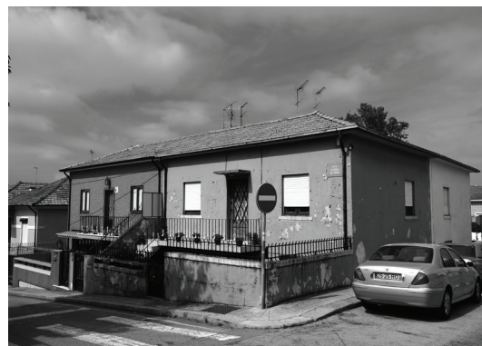
Fig. 86: Colónia de Estêvão Vasconcelos: vista da fachada frontal e lateral de uma casa quadripartida da fase de extensão do bairro.
