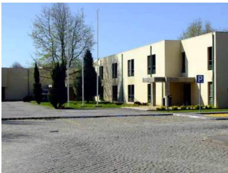
Fig. 28 – Antigas instalações da Escola na Rua dos Salazares.
