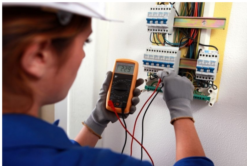
Figura 6.1: Verificação do quadro elétrico
