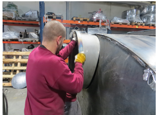
Figura 56 - Montagem da entrada de homem posterior
