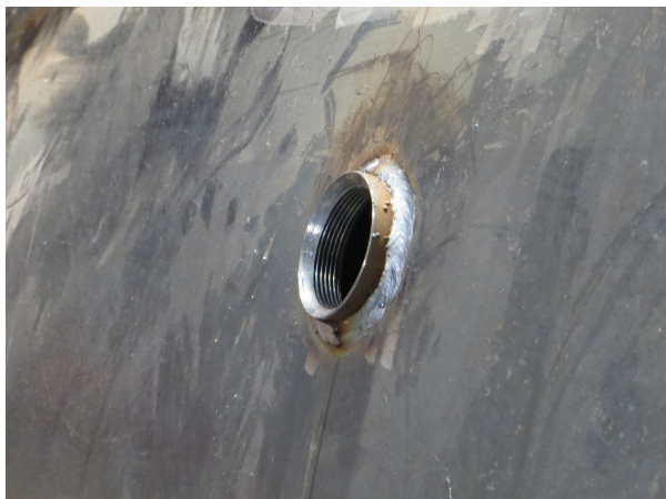
Figura 71 - Picagem para montagem de um visor
