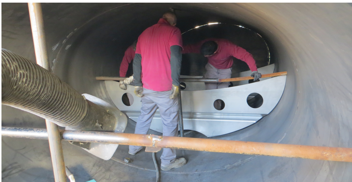
Figura 60 – Montagem das anteparas transversais superiores
