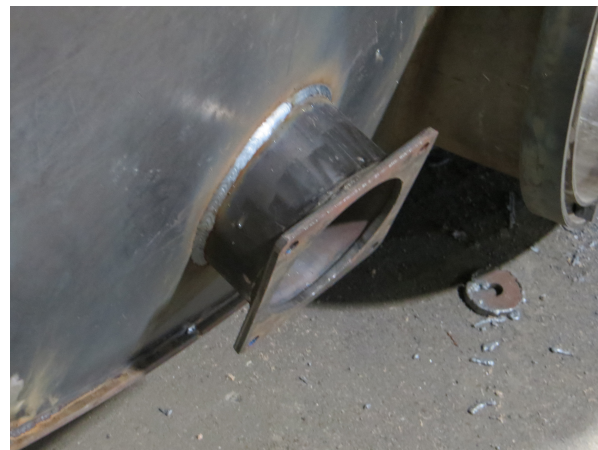
Figura 72 - Picagem para montagem da adufa posterior
