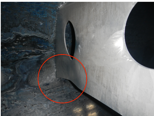
Figura 84 – Deformação de uma anteparas superior
