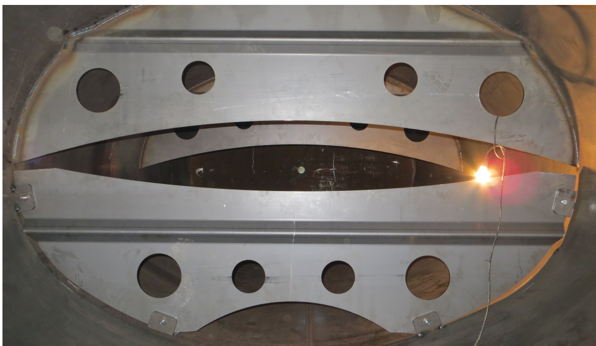
Figura 61 - Posicionamento da anteparada transversal inferior
