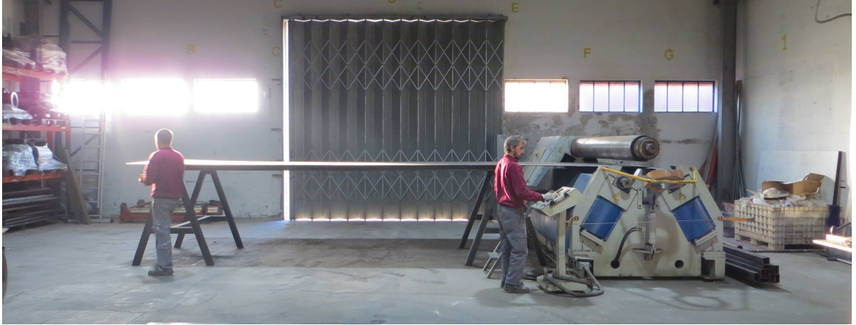
Figura 45 - Montagem e alinhamento da chapa na mesa da calandra
