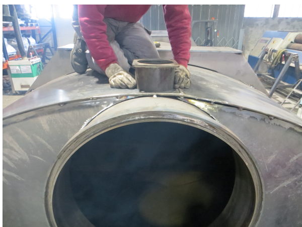
Figura 73 - Picagem para montagem da régua de espalhamento
