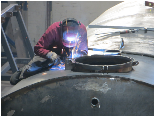
Figura 58 - Montagem da entrada de homem superior
