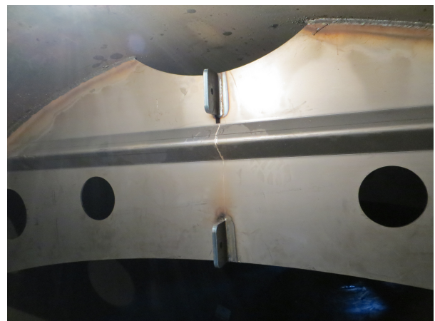
Figura 64 - Orelhas para fixação de antepara longitudinal
