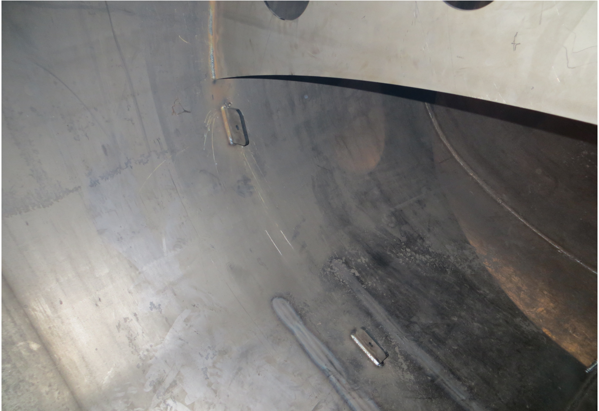
Figura 62 - Antepara transversal superior soldada e orelhas para montagem da antepara transversal inferior
