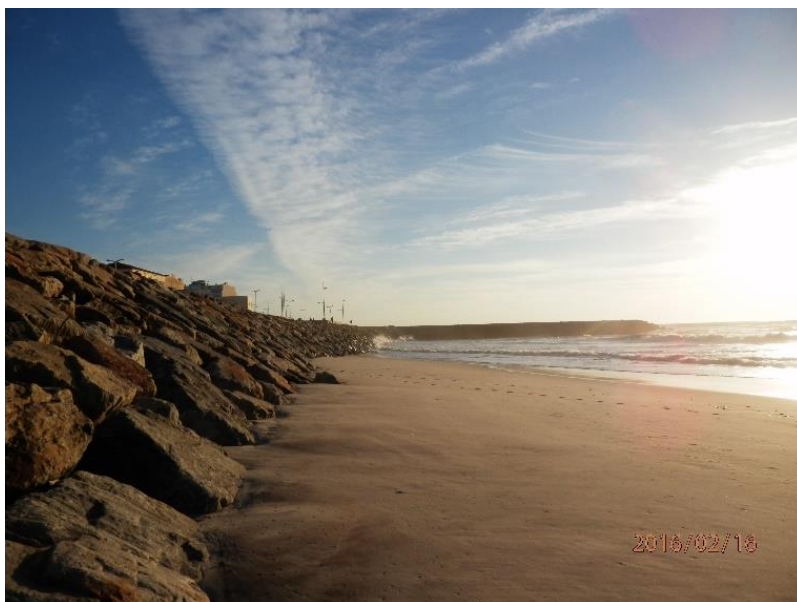
Figura 4.27 - Erosão a sotamar do esporão norte.
