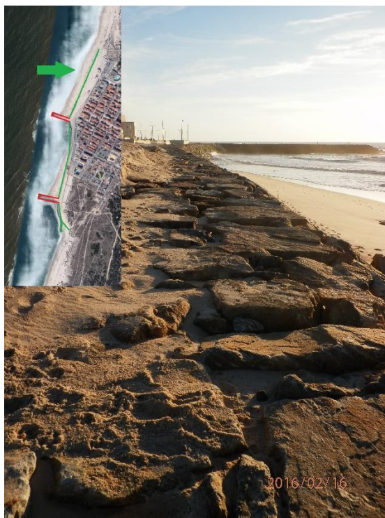
Figura 4.22 - Coroamento da estrutura aderente norte.
