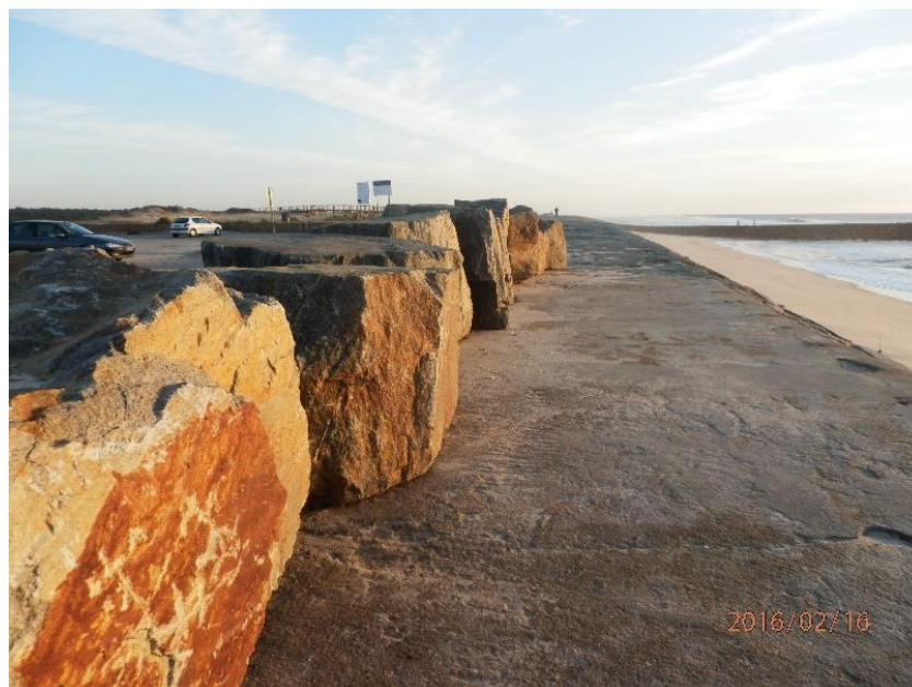
Figura 4.36 – Blocos no coroamento.
