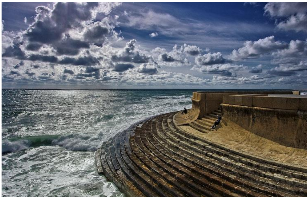
Figura 2.3 - Estrutura Aderente com forma de “meia laranja” da Granja [3].
