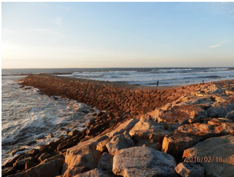
Figura 4.45 - Bom estado de conservação do esporão sul.
