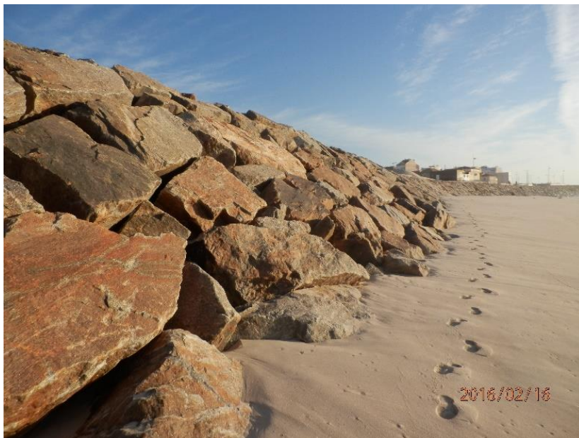
Figura 4.26 - Talude da estrutura aderente norte.
