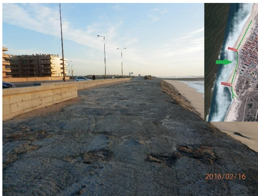
Figura 4.34 - Coroamento da estrutura aderente central.
