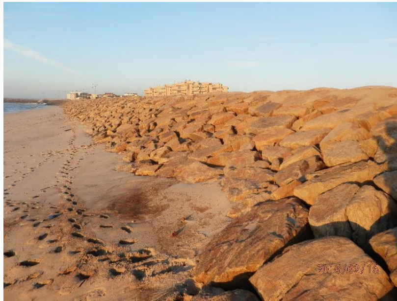
Figura 4.35 - Enrocamento da estrutura aderente central.
