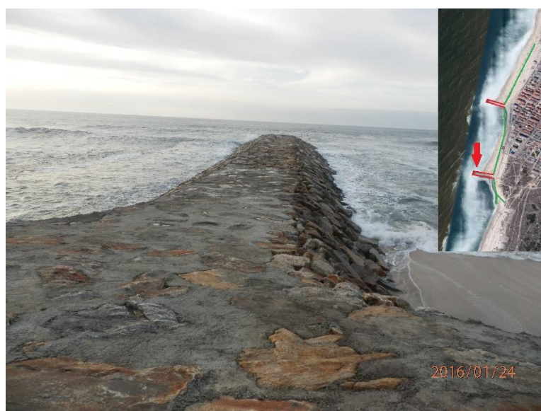
Figura 4.42 - Coroamento do esporão sul.
