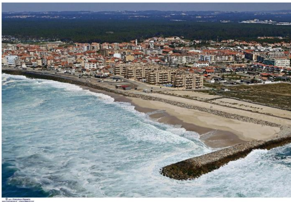
Figura 4.43 - Vista geral do esporão sul e estrutura aderente (Piqueiro, 2015).
