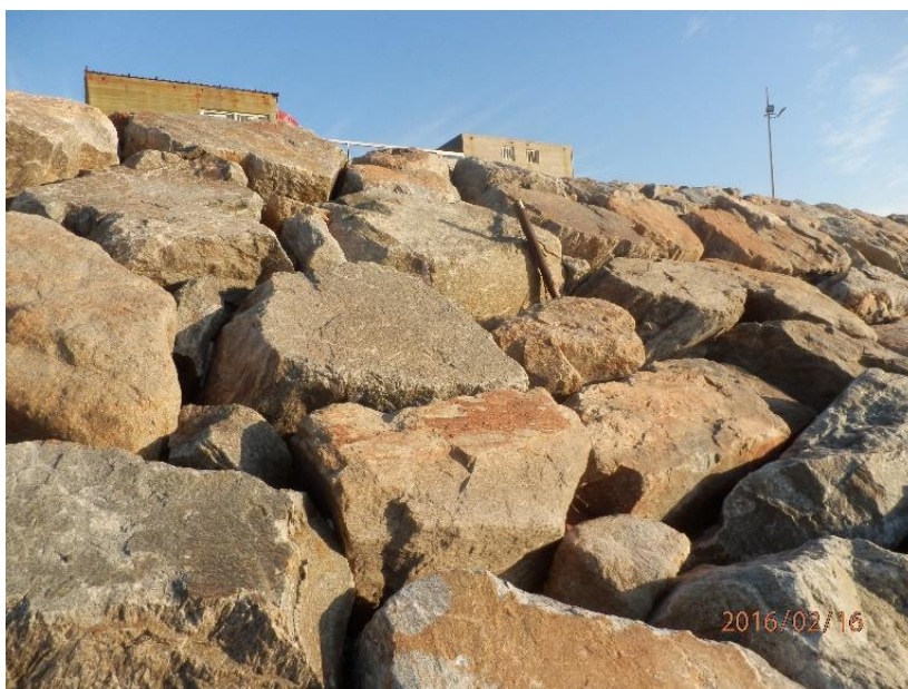
Figura 4.23 - Enrocamento da estrutura aderente norte.
