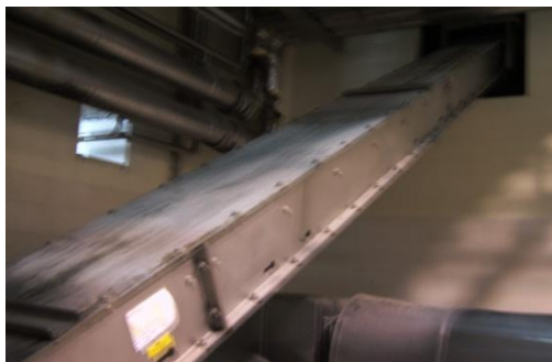
Figura 26. Transportador sem-fim de malte seco para a desradiculação.
