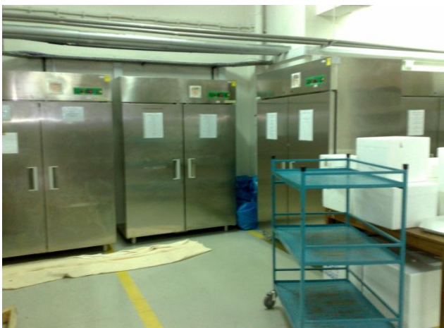
Fig. 13: Área frigorífica no armazém
