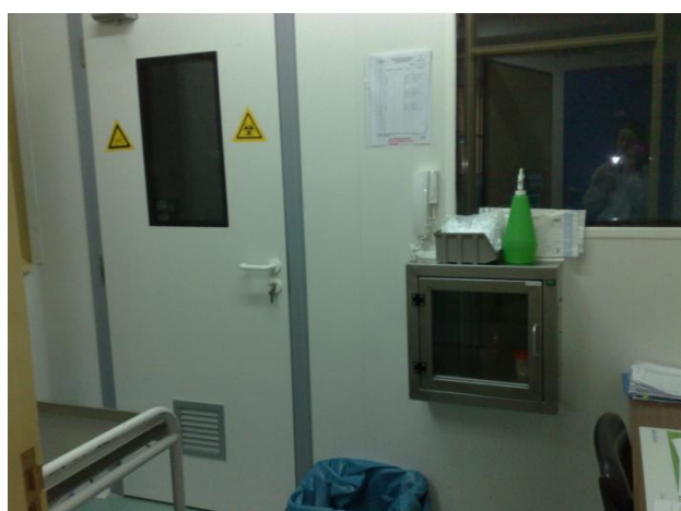
Fig. 24: Exterior da CFLv da UPC
