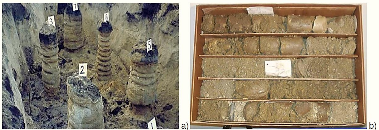
Figura 4.7 - Controlo de qualidade: a) execução de colunas teste; b) recolha de amostras (Costa Mateus, 2010)
