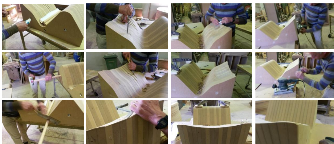
FIGURA 125: FINALIZAÇÃO DO MOLDE.
