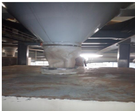
Figura 37 - Readaptação da manga de encaminhamento de granulado
