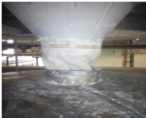
Figura 36 - Readaptação da manga de encaminhamento do caulino
