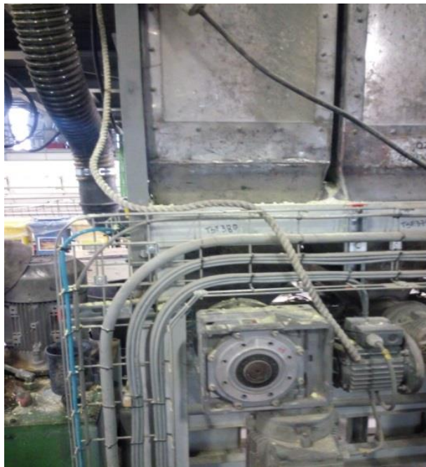
Figura 12 - Queda de produto durante o abastecimento dos cacifos para o piso inferior
