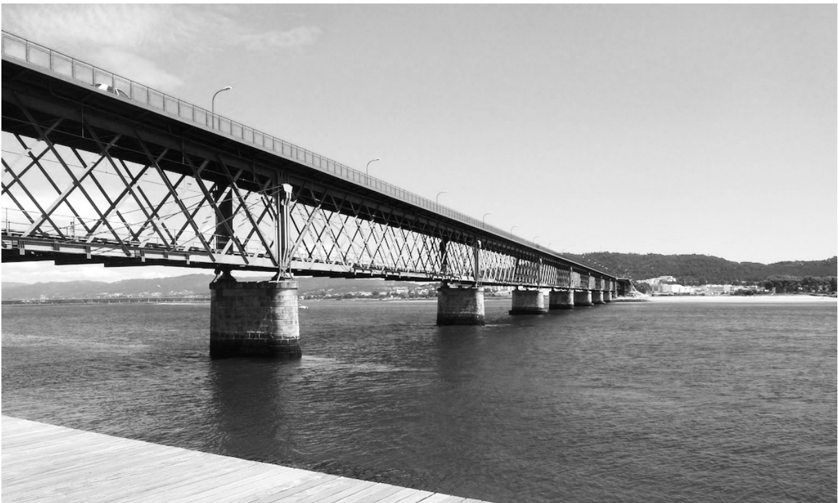
Fig. 1 - Uma das muitas infraestruturas produzidas durante o Fontismo - Ponte Eiffel de Viana do Castelo.
