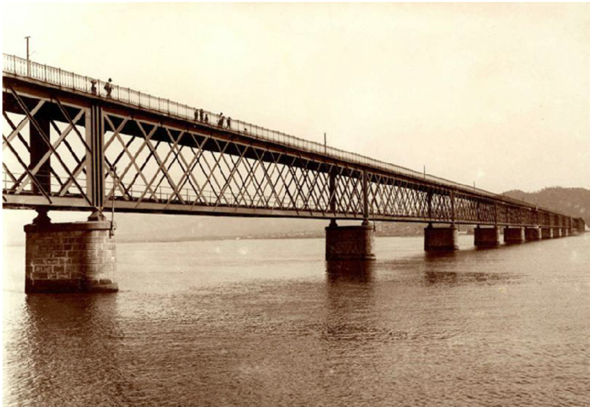
Fig. 17 - Vista da Ponte Eiffel do início do século XX.
