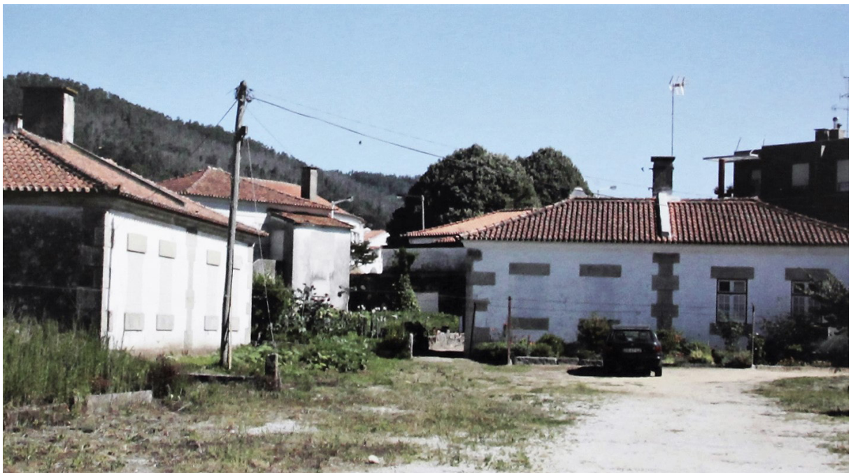
Fig. 49 - Vista do Bairro da CP no início do século XX, pode-se observar que muitos dos vãos já se encontravam encerrados.
