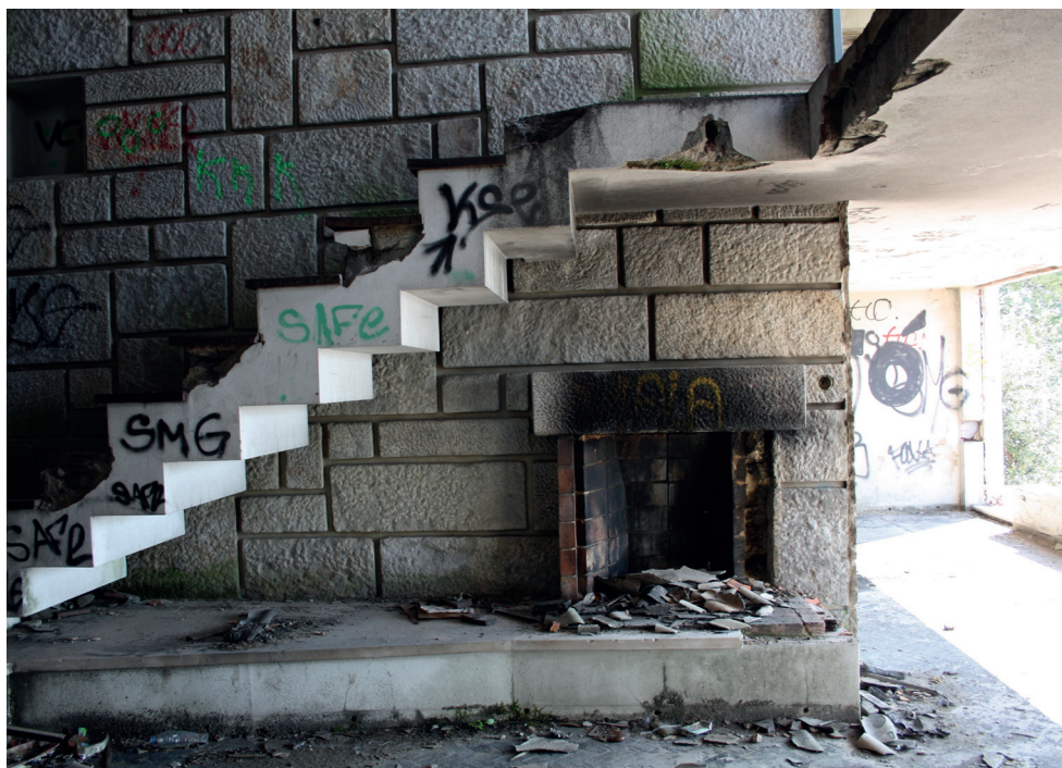
Sala de Estar. Acesso à mezzanine
