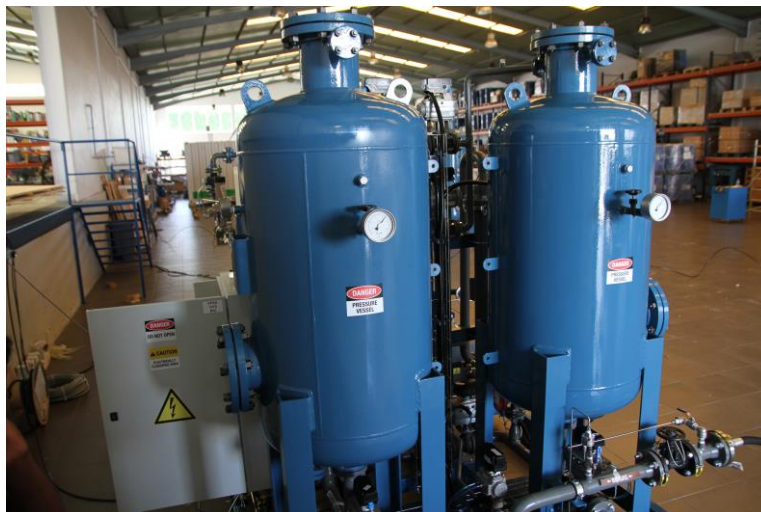
Figura 23 - Unidade industrial de captura de CO 2 construída pela Sysadvance.
