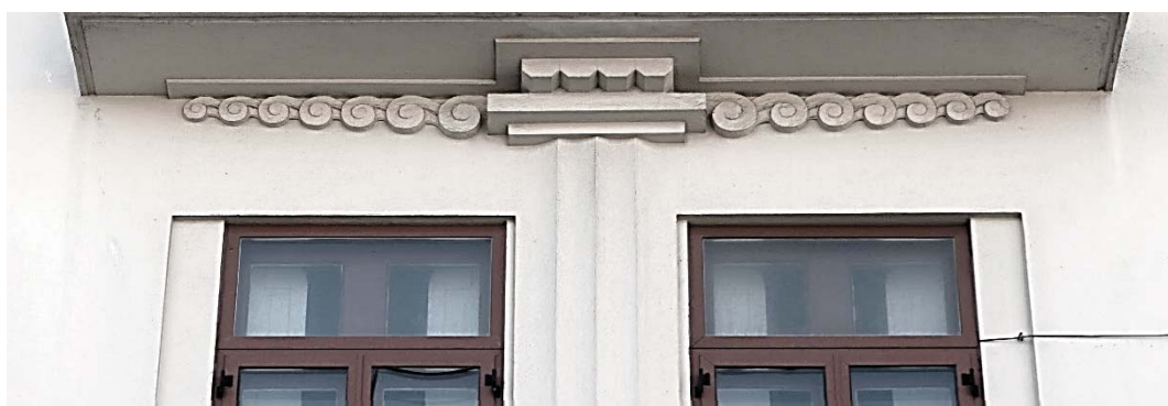
Edifício na rua Fernandes Tomás
