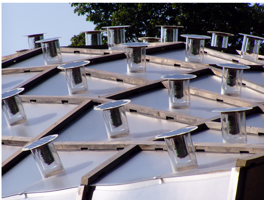
Figura 78 Vista da cobertura com a iluminação solar, Serpentine Pavilion (2005)
