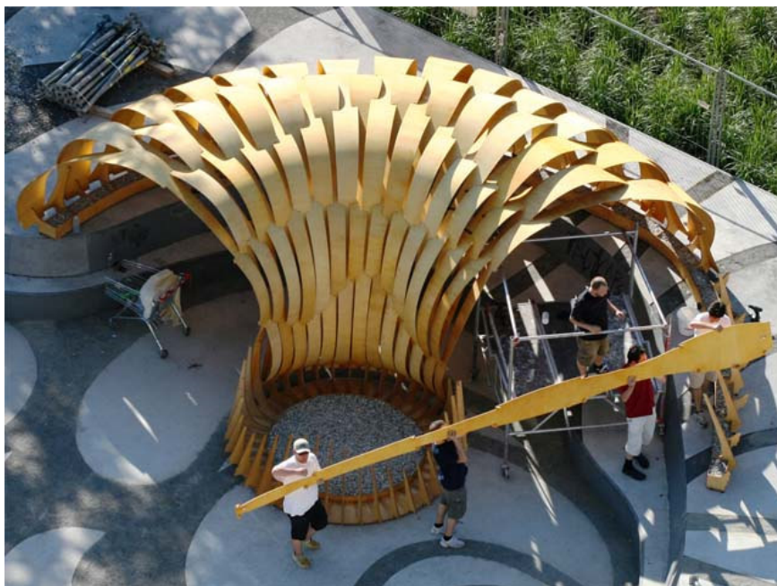
Figura 87 Montagem manual do pavilhão, ICD/ITKE Research Pavilion 2010
