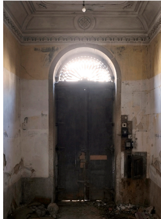
Fig.103 Porta Principal do Edifício
