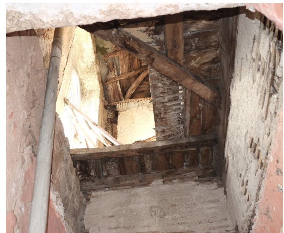
Fig.199 Último piso da torre
