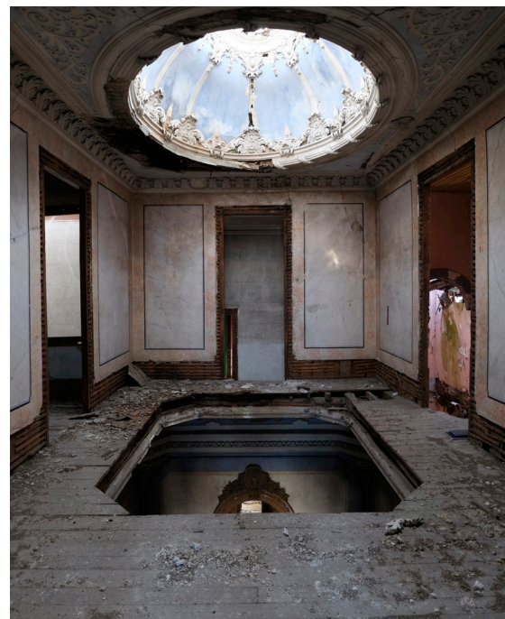
Fig.186 Galeria sobre a escadaria principal
