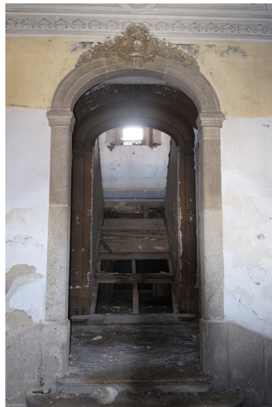
Fig.107 Porta do Hall da Escadaria
