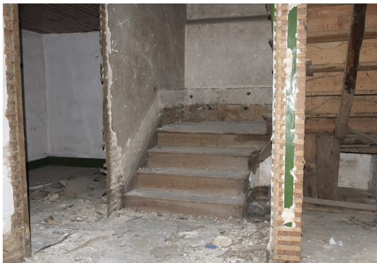
Fig. 149 Arranque da escada no meio piso
