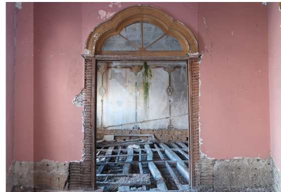
Fig.158 Vão comunicante com o Salão maior
