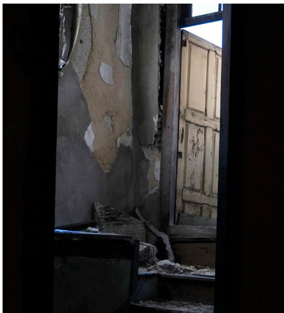
Fig. 188 Acesso à varanda
