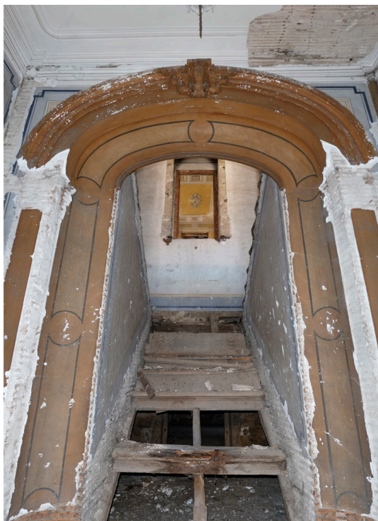
Fig.108 Acesso à Escadaria
