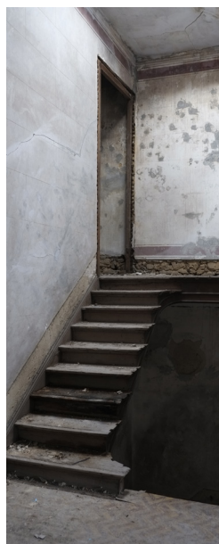
Fig. 151 Último lanço de escadas
