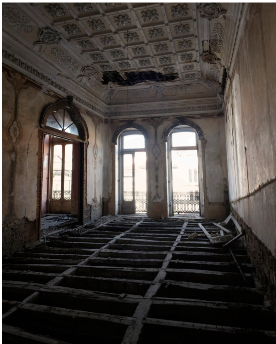
Fig.160 Vista geral do Salão
