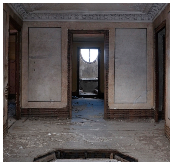
Fig.187 Alinhamento dos vãos com óculo do alçado principal
