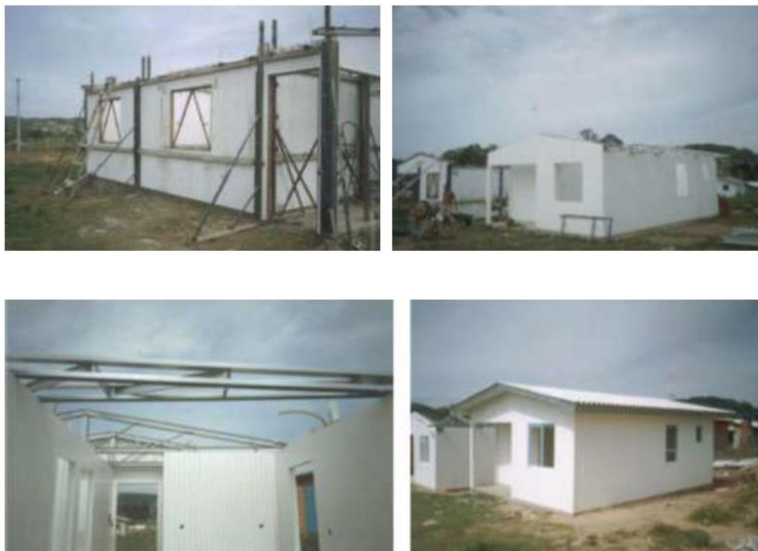
Figura 8: Sistema construtivo em painéis de PVC - Fase de montagem e obra concluída (Sousa 2011)
