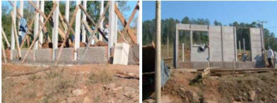
Figura 4: Sistema construtivo pré-fabricado em betão - Fase de construção (Sousa 2011)
