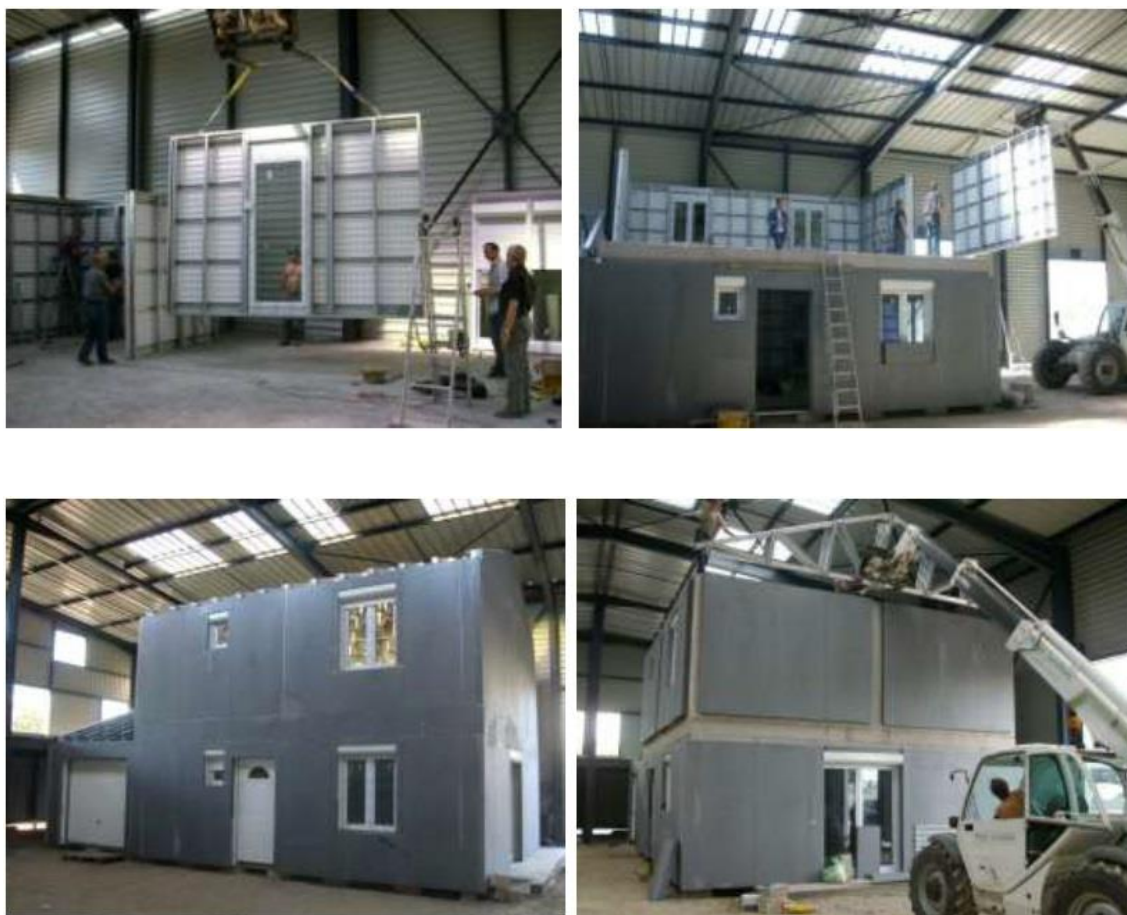
Figura 7: Sistema construtivo em painéis de aço galvanizado - Fase de montagem (System 2011)
