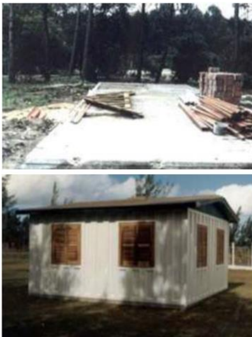
Figura 6: Sistema construtivo em painéis de fibra de vidro - Fase de construção e obra concluída (Sousa 2011)
