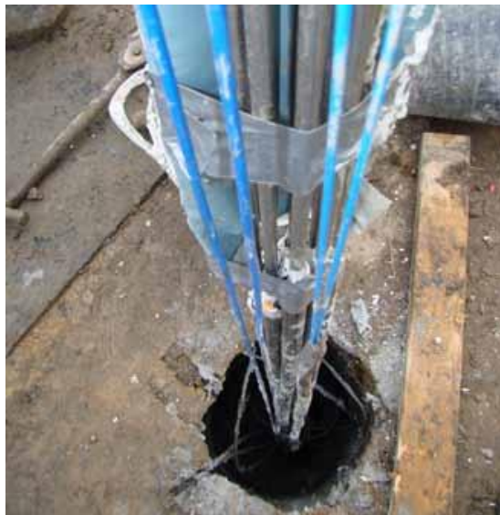
Figura 2.43 – Instalação de um sistema quasi-distribuído FBG num furo (Marmota Engineering AG, 2012)
