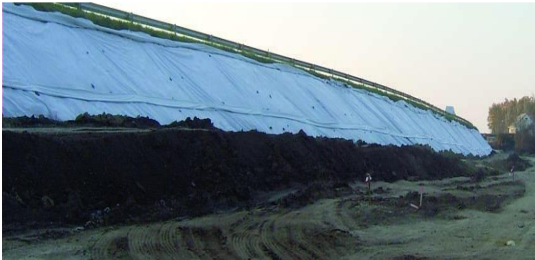
Figura 2.37 – Caso real de um sistema FO embutido num geotêxtil (TENCATE Geosynthetics, 2016)
