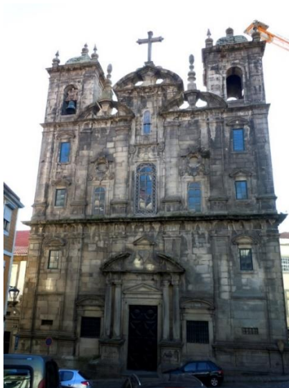
Fig. 5. Fachada principal da Igreja de São João Novo, no Porto. Fonte: Disponível em: http://www.portopatrimoniomundial.com/igreja-de-s-joatildeo-novo.html
