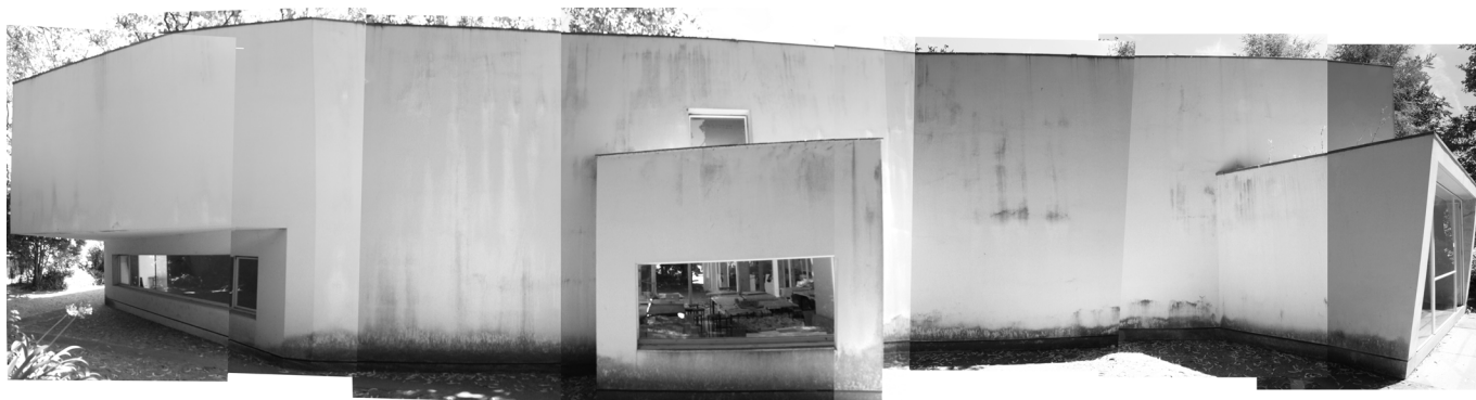
Pe1, Pe2, Pe4, Pe6, Pe12- Paredes exteriores viradas a norte e a noroeste
