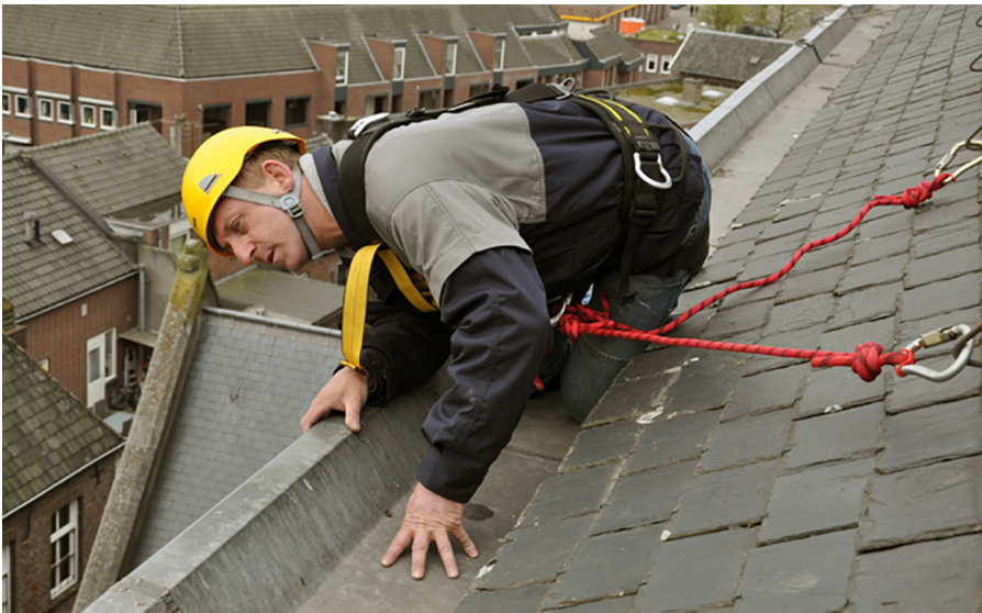
Figura2. Rotinas de inspeção e manutenção dos edifícios pelo Monumentenwatchen.
