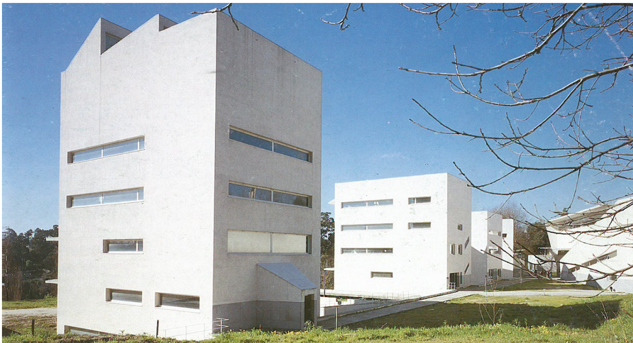
Figura17. Vista para os edifícios situados a sul e pátio exterior da FAUP.
