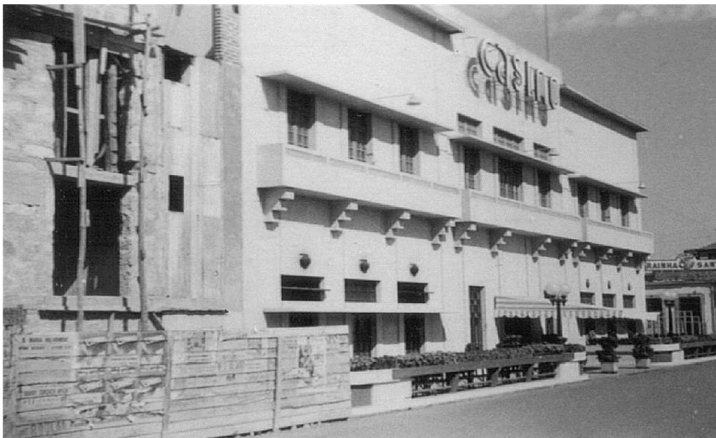
Cineteatro do Casino em construção, 1950.
