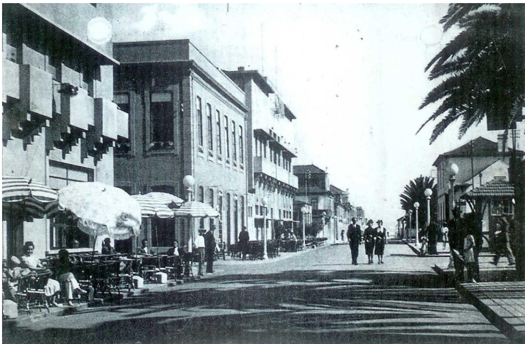
Esquina norte do Hotel Palácio, seguido do Café Chinês (outrora casino) e do edifício do Casino, nos anos 40.
