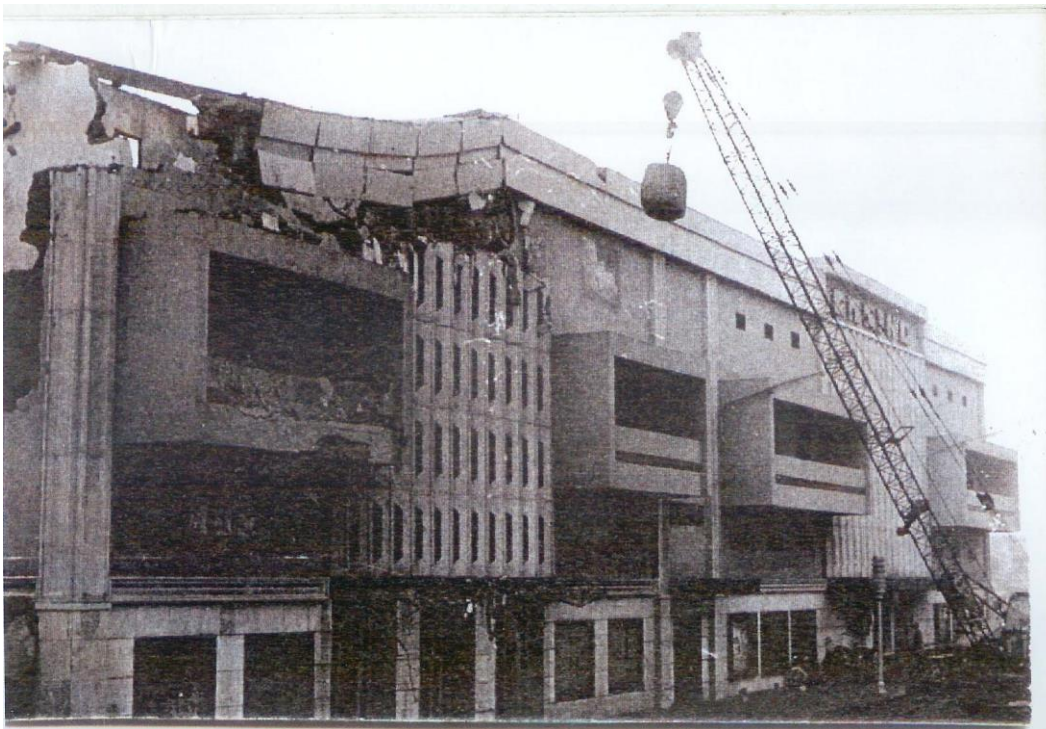
Demolição do Casino velho (2ª fase). Fonte: Coleção Particular.
