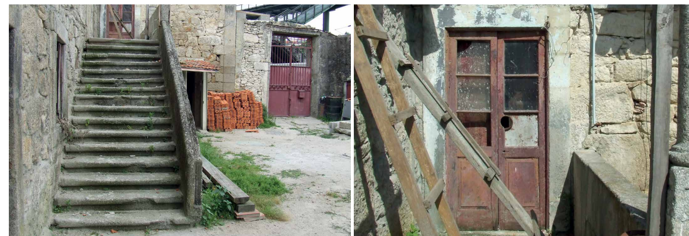
Figuras 550-553 - Comparando com o registo de Setembro de 2012 da fachada Nordeste observa-se a adição de um telheiro sobre a porta, criando um compartimento protegido e o destacamento do asfalto e dos rebocos das paredes.
