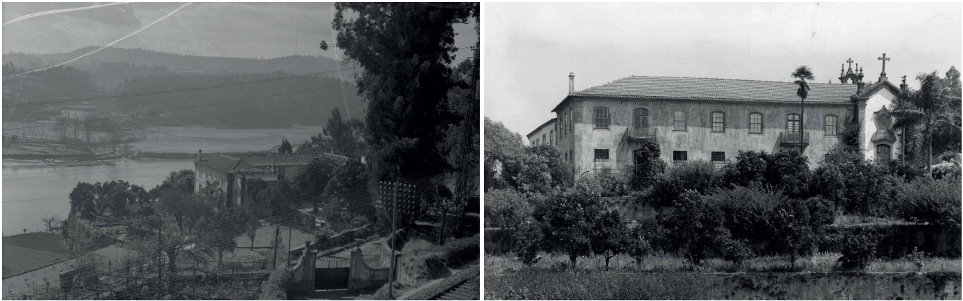
Figura 16 - Vista panorâmica da Quinta da China, rio Douro e Gaia, s.d. Figura 17 - Casa da Quinta da Revolta, 1961
