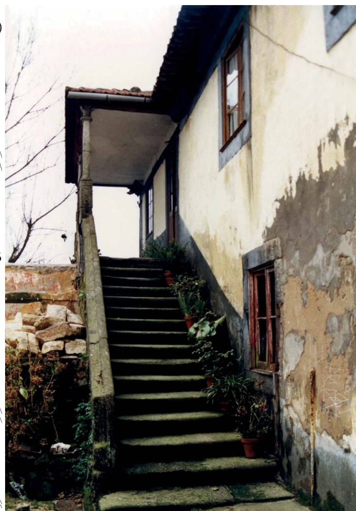
Figura 81 - Escadaria da casa da Quinta de Vila Meã, s.d.
