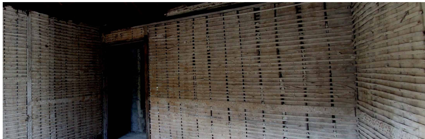
Figura 607 - Voltando ao corredor e acedendo-se ao espaço mais a Norte, encontra-se um compartimento definido por paredes de tabique simples.
