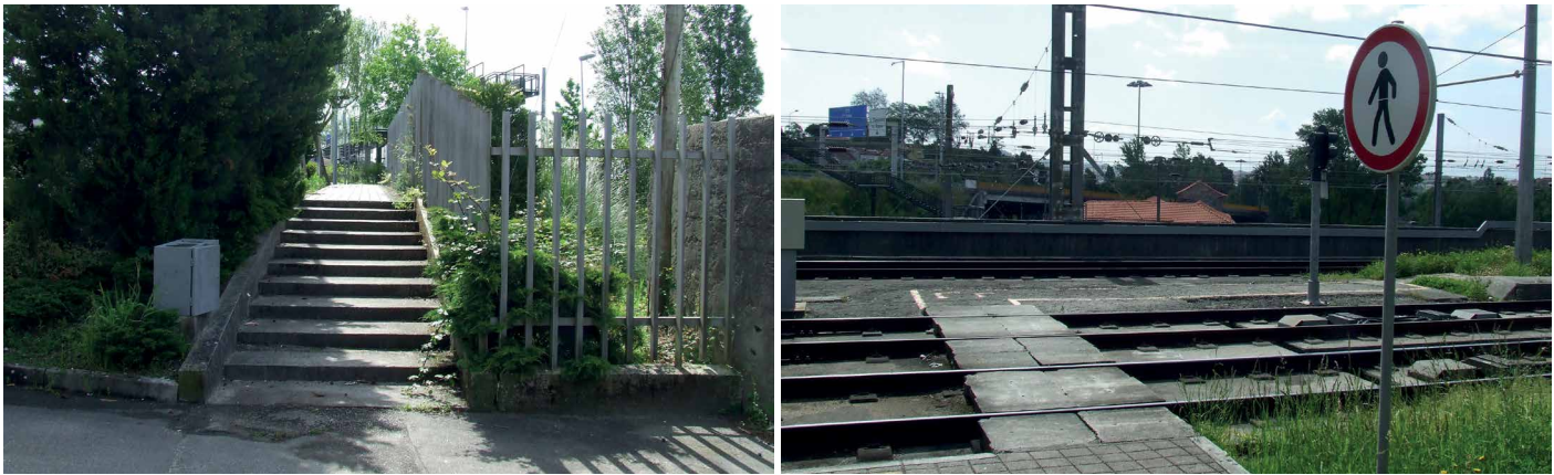
Figuras 464 e 465 - Prosseguindo-se o caminho em direcção a Nordeste, chega-se ao fim do percurso rodoviário, sendo o resto do caminho estritamente pedonal.
