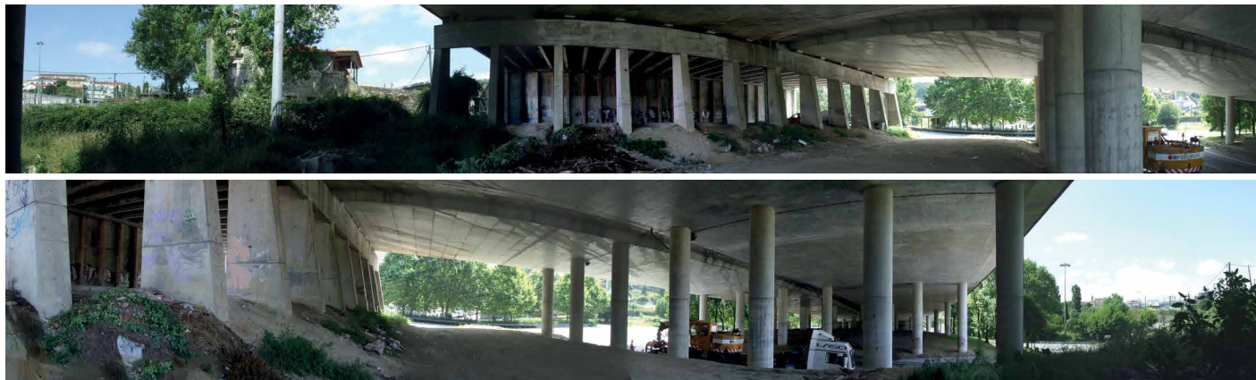
Figuras 446 e 447 - No referido espaço, com cerca de 650 metros quadrados, observa-se a monumentalidade e uma certa crueza que a estrutura do viaduto possui, em contraste com a escala humana da casa. Por outro lado, na primeira figura é ainda evidente a tensão Nascente-Poente que a fileira de pilares provoca.
