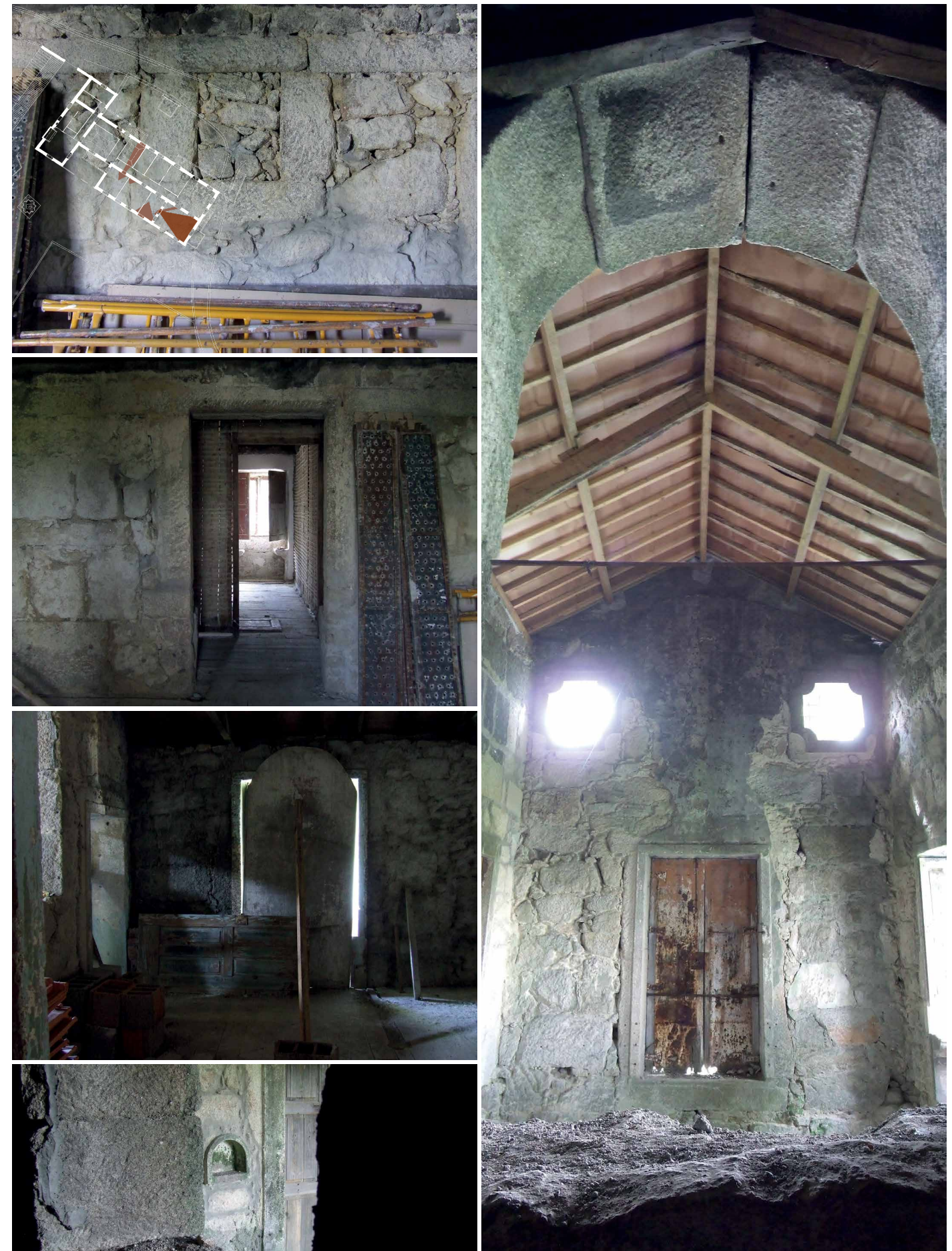
Figuras 599-603 - Apesar de não terem sido encontrados registos nesse sentido, o vão da primeira figura leva a especular que este volume terá sido o segundo a ser construído, enquanto o adjacente, paralelo e de maior comprimento, poderia ter sido adicionado para ampliar a casa de habitação e, ao mesmo tempo, efectuar a ligação à casa primitiva. Contudo, poderá tratar-se somente de uma janela interior, comunicante com o corredor de distribuição. A partir deste ponto é igualmente possível ver um elemento em madeira que pertencia claramente ao altar e, através desse mesmo vão, obtém-se uma relação visual com o que era a nave da capela e respectivo acesso pela escadaria exterior, com os óculos que se observam do exterior e com o que aparenta tratar-se de um pequeno nicho junto a um acesso lateral. A estrutura do telhado aparenta ser integralmente nova.
