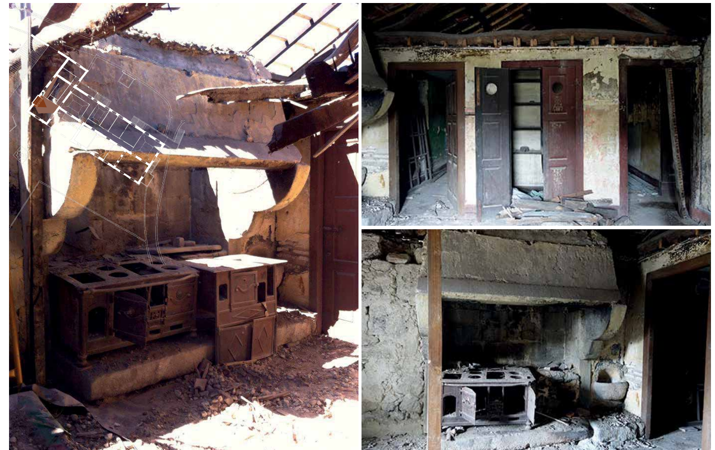
Figuras 561-563 - No registo de Agosto de 2014, a cozinha encontrava-se destelhada, enquanto em Outubro 2015 aparentava já se encontrar coberta.
