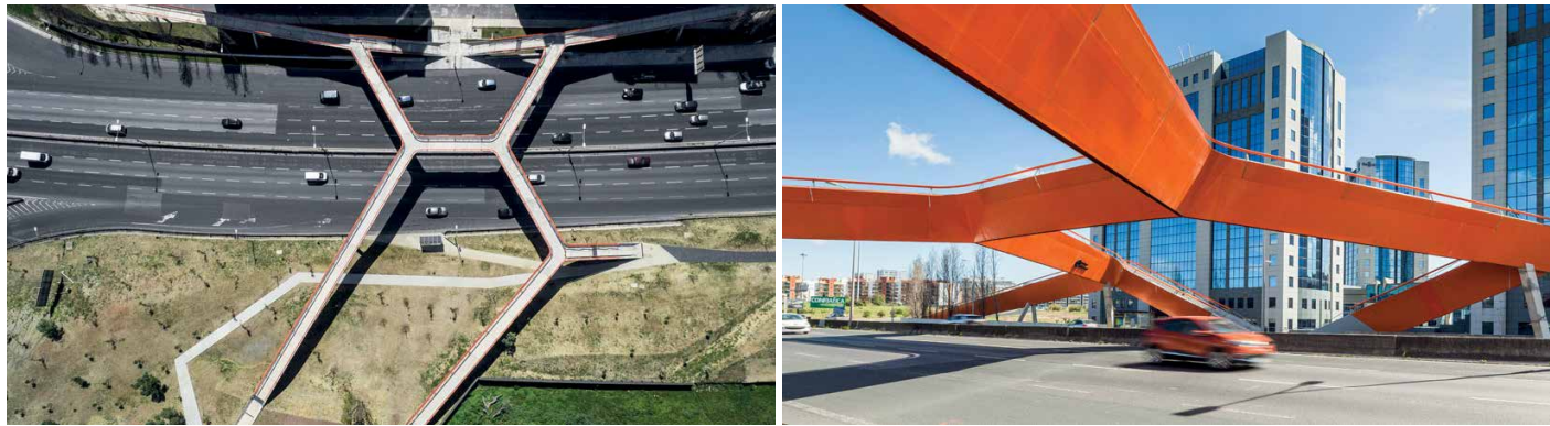
Figuras 725 e 726 - Vistas da ponte pedonal e ciclável sobre a Segunda Circular, Lisboa, MXT Studio, 2015
