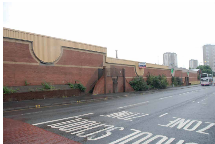
Figura 335 - Armazéns da BBC antes da intervenção, Glasgow, s.d.
