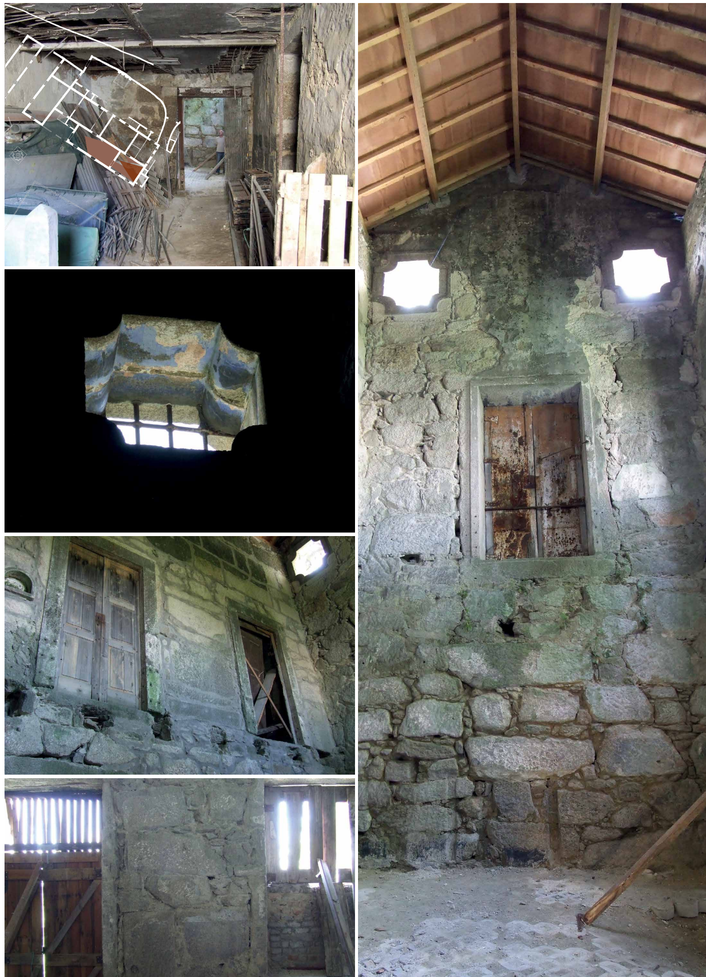
Figuras 650-654 - Ao seguir-se para Sudeste, afere-se que foi colocada uma viga metálica no apoio do vão que liga o corredor ao espaço da capela. Este poderá ter sido colocado em substituição de um lintel em pedra danificado ou então resultou da necessidade de se efectuar uma nova abertura de comunicação entre estes espaços. Por outro lado, deste ponto de vista observam-se os óculos, que contêm vestígios de tinta azul nas faces internas, e a face interna dos vãos semi-emparedados com tijolo burro.
