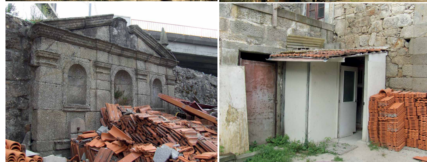
Figuras 550-553 - Comparando com o registo de Setembro de 2012 da fachada Nordeste observa-se a adição de um telheiro sobre a porta, criando um compartimento protegido e o destacamento do asfalto e dos rebocos das paredes.
