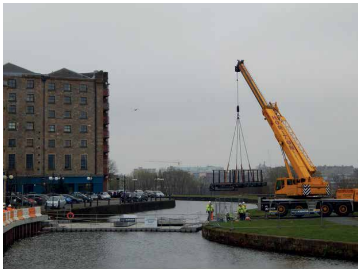
Figura 371 - Colocação de ponte em Speirs Wharf, 2014
