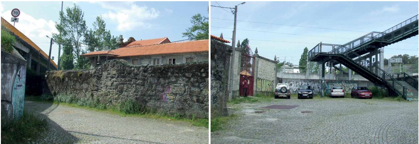
Figuras 452 e 453 - Após a passagem por baixo do viaduto, é visível o muro de granito que desenha o limite Norte da quinta, o portão de acesso ao volume mais antigo da casa e o limite Oeste, definido pelo muro de delimitação dos caminhos de ferro. Por cima desta última estrutura, a ponte pedonal que permite o acesso Poente à quinta.
