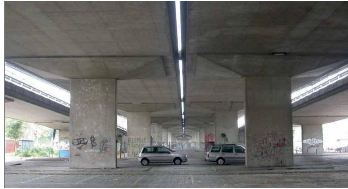
Figura 377 - Zona inferior do viaduto, 2004
