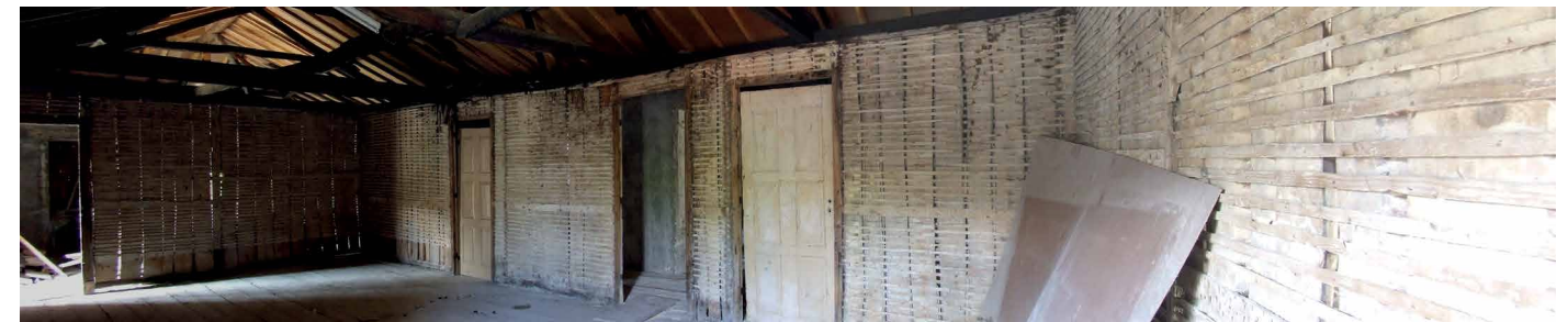
Figuras 608-611 - Olhando para a estrutura do telhado, depreende-se que se mantiveram o pau de fileira, as madres, as pernas e os níveis, e que se substituíram as varas, tendo-se aplicado um guarda pó que aparenta ser constituído por painéis em platex . Como é possível constatar no levantamento efectuado pelo IPAP, quer este espaço quer o que se situa no extremo Sudeste, no mesmo enfiamento, também continham tectos em masseira. Segundo o responsável da Junta de Freguesia de Campanhã, os painéis foram retirados para serem restaurados e colocados novamente pela equipa que se encontrava a ter formação no espaço da casa, para isso colocando o revestimento a preto, visível sobre alguns elementos em madeira (possivelmente tinta de óleo, zarcão ou alcatrão). No geral, o sobrado da casa aparenta estar em boas condições, havendo somente alguns pontos em que o tabuado abateu.
