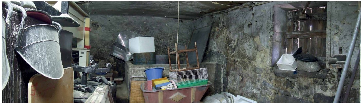
Figura 643 - Após a entrada pela porta contígua à anterior e ao chegar a um corredor largo, encontra-se, do lado direito, o lagar. Ao fundo deste espaço terá existido uma abertura ou passagem, que aparenta ter tipo emparedada, apesar de não ser completamente verificável, visto esta parede ainda conservar a maior parte do reboco. Nota-se que esta parte da casa tem um tratamento mais austero, dado ligar-se mais directamente com as actividades agrícolas da quinta.
