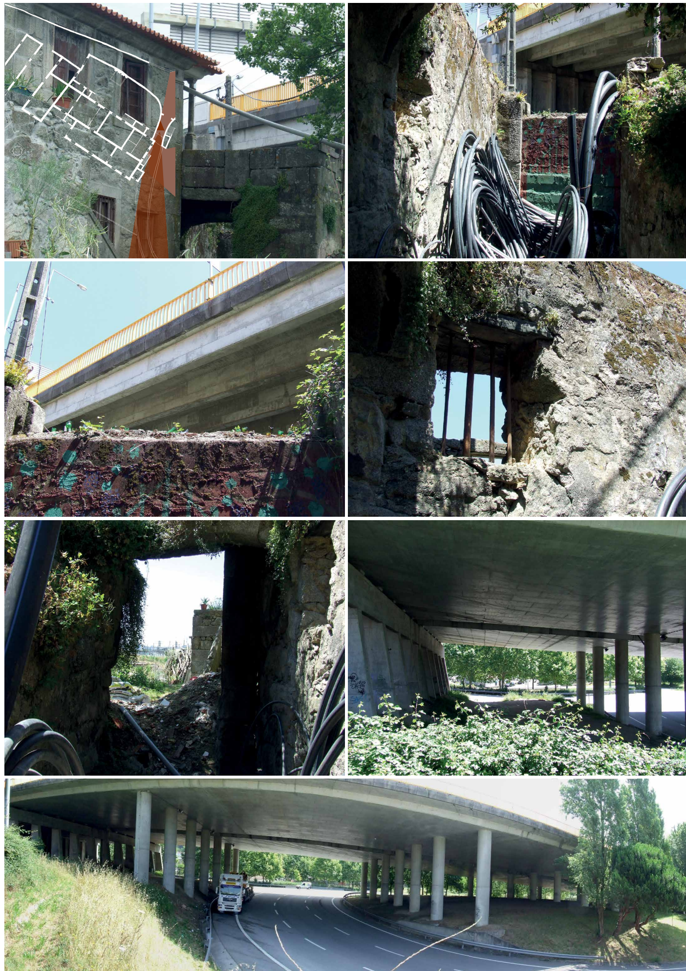
Figuras 529-535 - Deste ponto é possível observar-se a escadaria que, em salto sobre o muro, permitia o acesso aos terrenos agrícolas e o local onde estaria o portão, tapado por uma parede e um vão que possibilitaria a relação visual entre os dois lados da casa. Recuando, existe uma relação visual directa com o espaço por baixo do viaduto e a denominada rotunda de Bonjóia.
