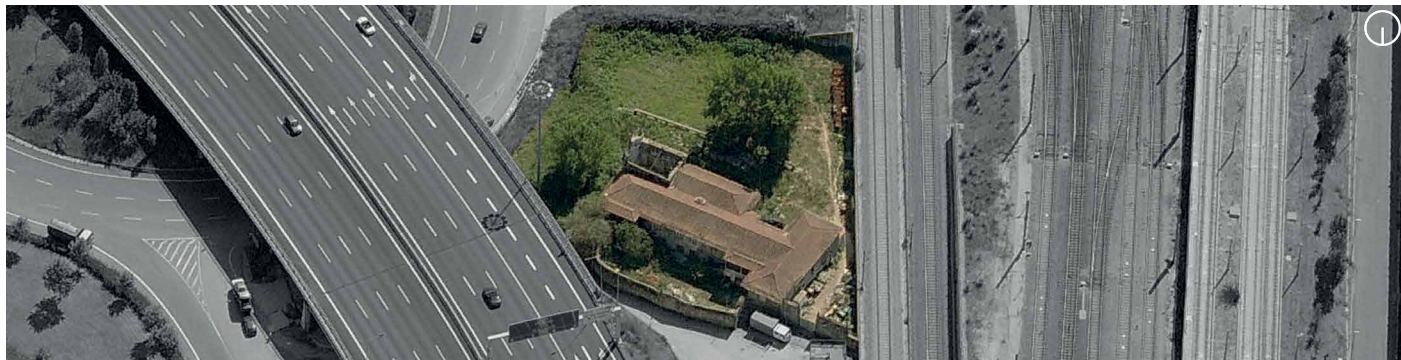
Figura 151 - Vista aérea, lado Norte, 2015
