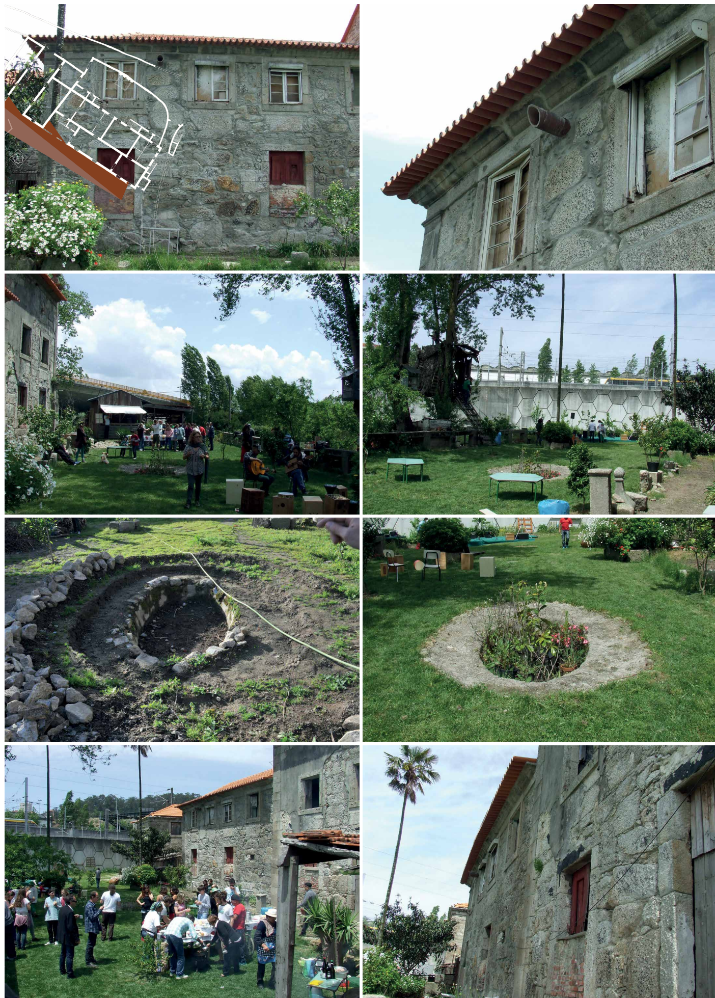
Figuras 502-509 - No alçado Sul nota-se a colocação de um tubo com algum diâmetro na alvenaria, que se supõe destinar-se a ventilação. No piso térreo, como a pedra se encontra exposta, verifica-se que houve o fechamento de metade dos vãos das janelas, facto referido no levantamento do IPAP. Enquanto o muro de separação entre o pátio e o jardim foi retirado, o lago central persistiu, alterado depois de Março de 2014.
