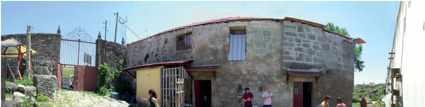
Figuras 474 e 475 - Na vista do topo Norte observa-se o portão de acesso ao volume mais antigo da casa, com a eira, um pátio e um laranjal no enfiamento. No topo Norte do edifício observa-se a adição de uma persiana e o revestimento recente da alvenaria de granito com reboco.
