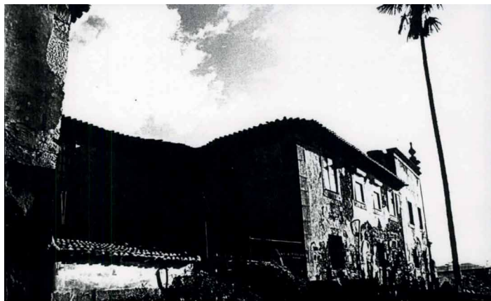
Figura 109 - Vista aproximada da fachada Sudoeste, em que se verifica um anexo do lado esquerdo, em baixo, e as duas janelas superiores, do lado direito, que correspondem à única nave da capela, situada no andar superior.
