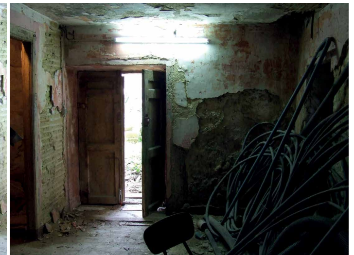
Figuras 632-635 - Ao passar a porta protegida pelo patim prolongado, deparamo-nos com uma série de três espaços comunicantes entre si, que, apesar da deterioração, ainda conservam a maior parte dos revestimentos das paredes e tectos, deixando ver o fasquiado por detrás do reboco e a pintura de acabamento.
