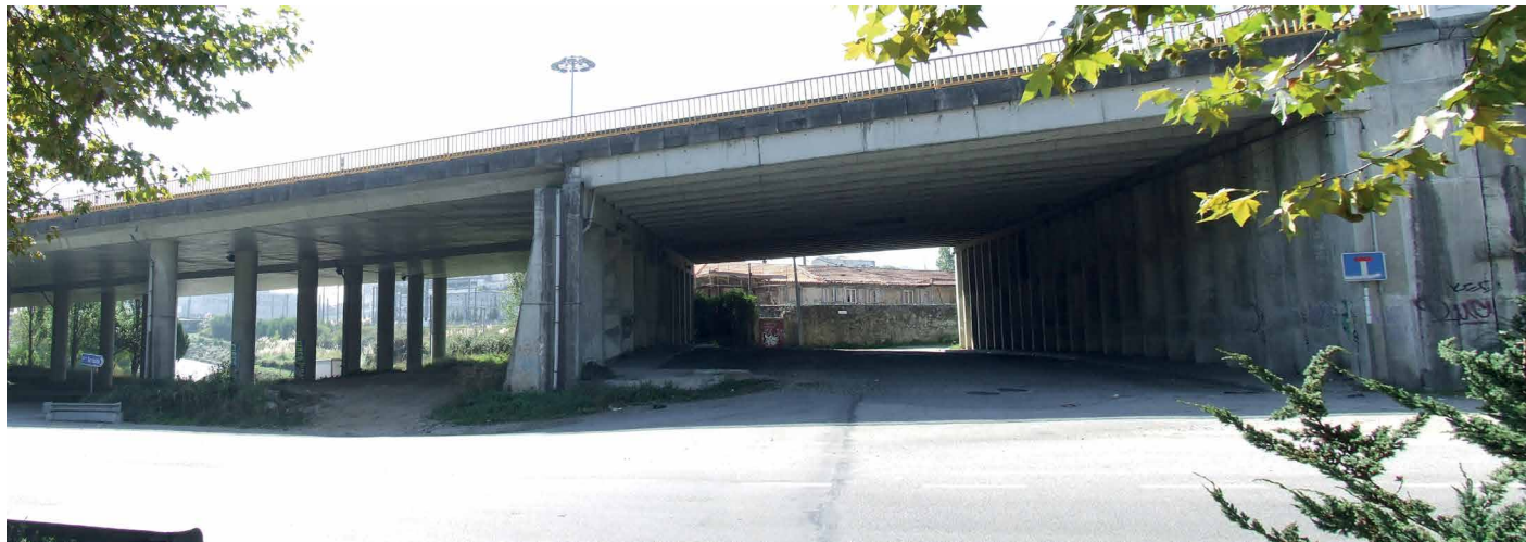
Figuras 442 e 443 - A chegada por nascente à quinta é efectuada por baixo do viaduto da VCI. A falta de limpeza, manutenção e luminosidade tornam este acesso pouco convidativo ou atractivo aos automobilistas. Por outro lado, o atravessamento pedonal desta via revela-se perigoso devido à fraca visibilidade e à velocidade dos veículos que aumenta com a proximidade do ramal de acesso à estrada.
