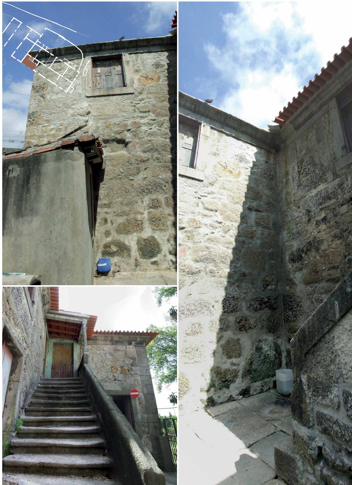
Figuras 492-494 - Este ponto permite o acesso à zona do lagar, no piso térreo, bem como a subida ao piso superior pela escadaria rematada pelo patim alpendrado, cujas guardas são de pedra afeiçãoada à mão. Neste alpendre, as cantarias de granito das portas de acesso ao interior têm vestígios de tinta verde, como se verifica noutros pontos da casa. Nesta série é também de salientar a ausência de cunhal no volume mais antigo da casa, comparativamente com o mais recente, cujas esquinas são rematadas por cunhais em granito.
