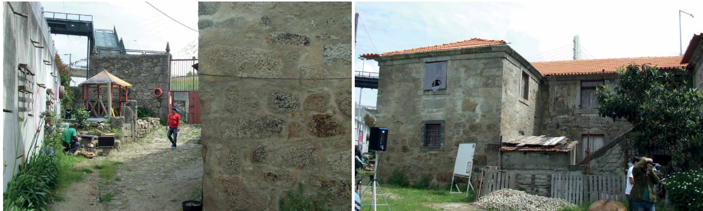
Figuras 485 e 486 - Ao seguir na direcção Sul, para onde se localizaria a eira, e olhando-se para a frente Sudoeste da casa, nota-se a adição de um elemento junto à casa, que de momento serve de casota de cão. Seria sensivelmente neste ponto onde se localizava o chafariz.
