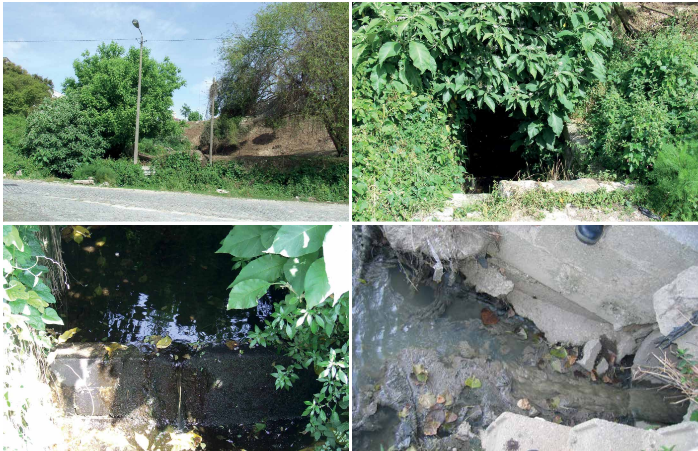
Figuras 458-461 - No lado Poente do caminho observa-se um curso de água que se deverá tratar da Ribeira de Vila Meã, cuja foz se pode observar na última figura, registada em Outubro de 2007.
