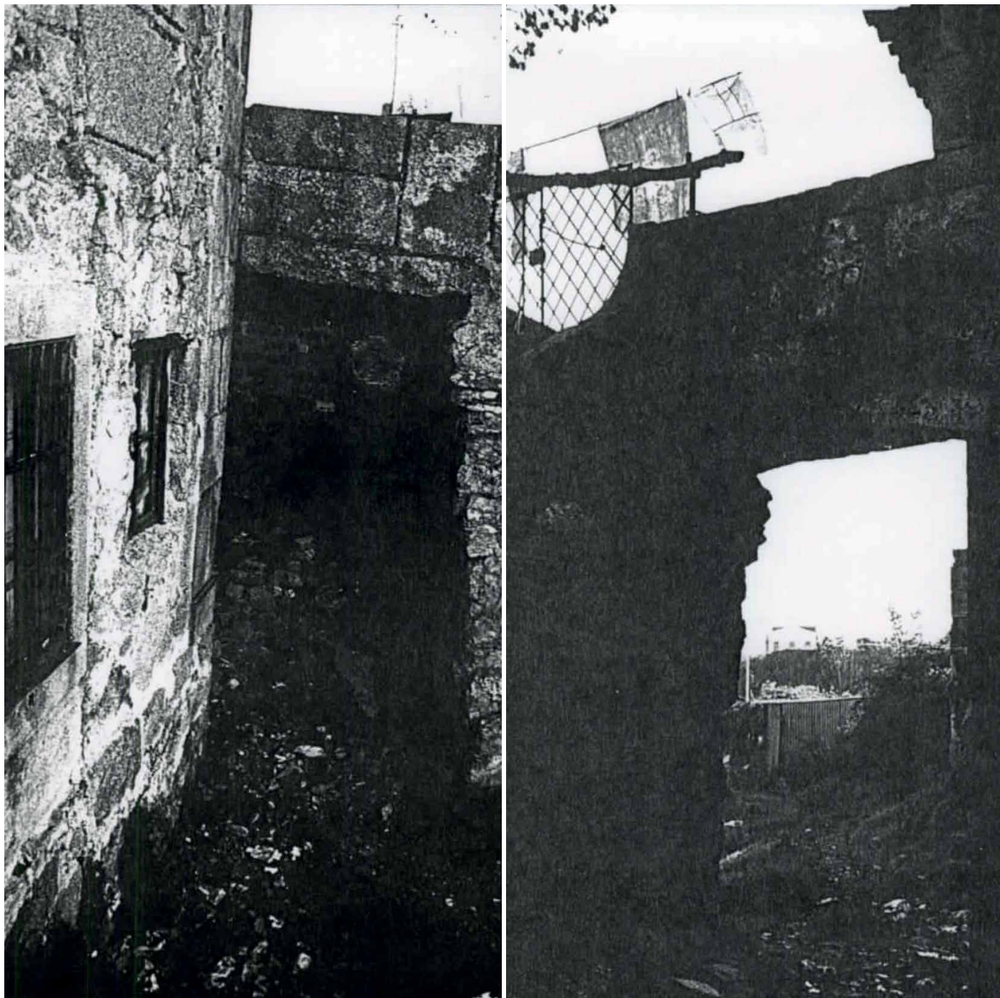
Figuras 117 e 118 - Vista da passagem debaixo da escadaria que faria o acesso do povo aos actos litúrgicos, e da passagem superior que permite o acesso do andar nobre da casa aos terrenos da quinta. Quer o passadiço quer a escada avançam e ultrapassam a passagem, com muros altos, entre o terreiro e a antiga zona agrícola da quinta.
