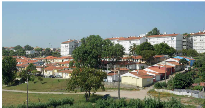
Figura 211 - Vista do bairro Prodac, 2012
