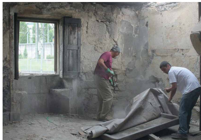
Figuras 158 e 159 - Recuperação do telhado e interiores, Agosto 2014
