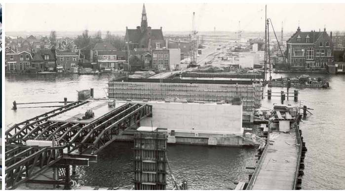
Figura 376 - Construção da auto estrada, s.d.
