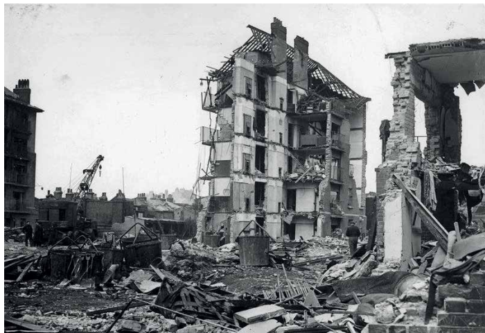
Figura 177 - Edifícios em ruínas após bombardeamento, Londres, 1945
