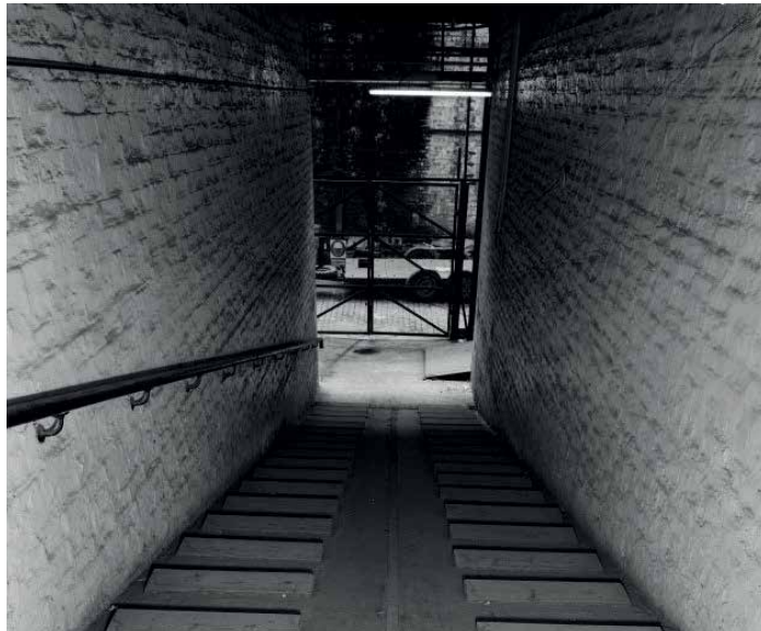
Figura 403 - Vista da rampa de acesso aos estábulos, 1987
