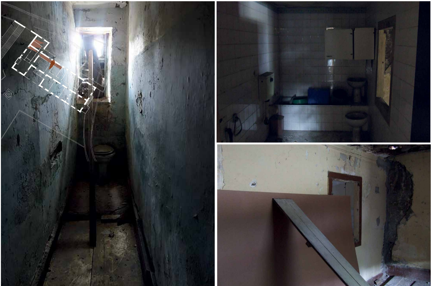
Figuras 573-575 - Por detrás da primeira porta do corredor encontra-se o espaço exíguo que resultou da construção de uma parede a meio do vão, o que, por outro lado, permitiu a entrada de luz natural no que aparentam ser uns lavabos. A mesma procura de luz deverá ter levado igualmente à abertura de um vão para um espaço que seria usado como quarto, criando uma suite.
