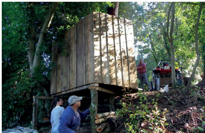
Figura 289 - Construção da casa de banho, Outubro 2013
