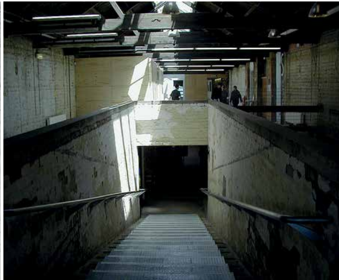
Figura 404 - Vista da antiga rampa de acesso aos estábulos, s.d.
