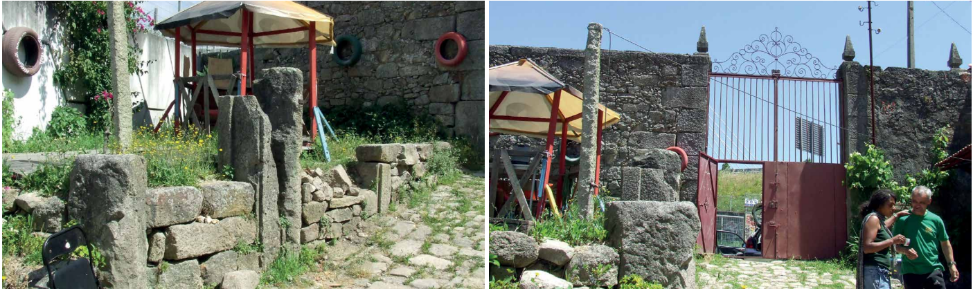
Figuras 476-480 - Após a passagem pelo portão, observa-se a frente Noroeste do volume mais antigo da casa, onde, no beirado, faltam as cornijas, que ainda deverão estar espalhadas pelo terreno, como se verifica na quarta figura. Ademais, verifica-se também a divisão de um vão com tijolo burro e a adição de uma construção sob um telheiro existente. Por outro lado, no extremo direito da fachada observa-se a saliência do volume da lareira da cozinha (cujas juntas aparentam ter sido preenchidas com argamassa cimentícia), suportado por duas mísulas. Junto a este volume encontra-se um elemento em granito, partido, que aparenta ter sido um anel circular. O vão de tensão vertical, com proporção de porta, poderia ter sido onde se encostava a escadaria de acesso ao piso superior quando só existia este volume.
