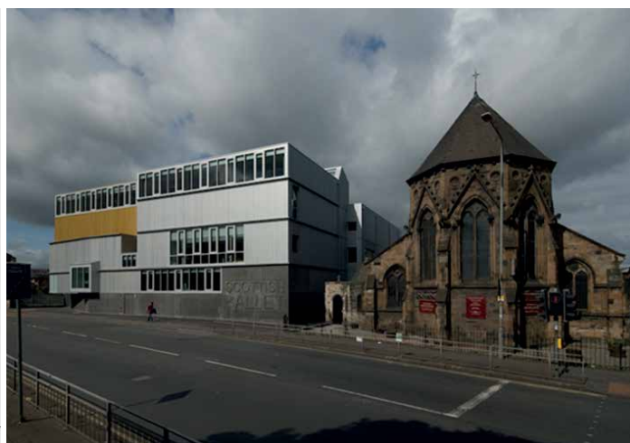
Figura 414 - Vista do lado Este do Scottish Ballet, 2011
