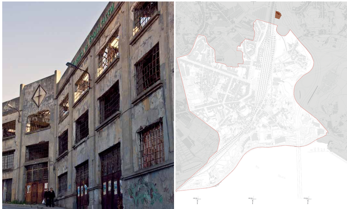
Figura 45 - Fábrica de Esmaltagem Mário Navega, demolida em 2011 Figura 46 - Planta do limite da ARU de Campanhã - Estação, 2015
