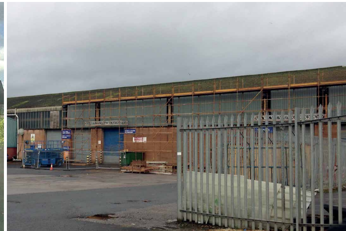
Figura 367 - Obras do National Theatre of Scotland, Janeiro 2015
