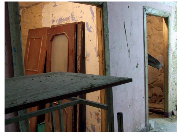
Figuras 632-635 - Ao passar a porta protegida pelo patim prolongado, deparamo-nos com uma série de três espaços comunicantes entre si, que, apesar da deterioração, ainda conservam a maior parte dos revestimentos das paredes e tectos, deixando ver o fasquiado por detrás do reboco e a pintura de acabamento.
