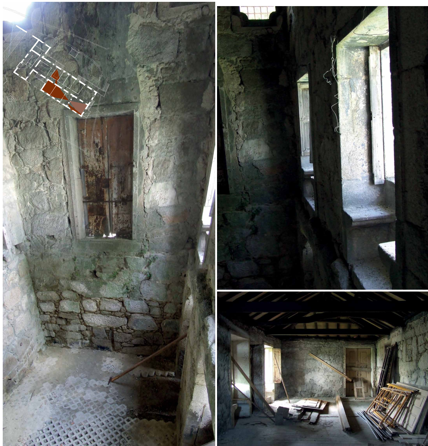
Figuras 604-606 - Observando-se as paredes ao nível do sobrado desaparecido, notam-se as entregas do seu vigamento. Ao nível inferior, encontra-se em execução o revestimento do seu pavimento através de elementos hexagonais prefabricados em betão. Do lado direito, orientado a Sudoeste, encontram-se duas janelas de peito com duas namoradeiras cada. Virando-se o campo de visão para o lado oposto, tem-se a leitura do espaço percorrido até à capela.
