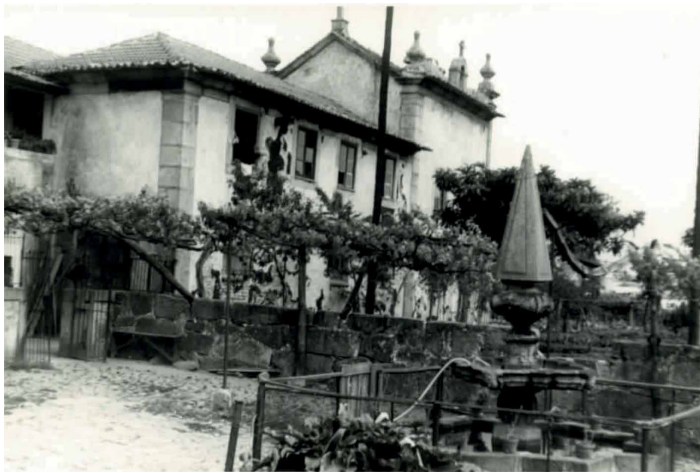
Figura 93 - Vista Sudoeste da casa, 1972
