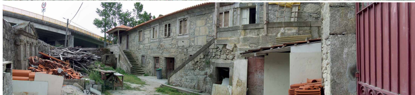
Figuras 547-549 - Sobre o portão, observam-se em falta os elementos já referidos, tais como o brasão de família e os coruchéus. Após a passagem pelo portão acede-se ao que poderia ser classificado como a zona nobre da casa, com a fonte junto ao muro e as escadarias simétricas de acesso ao piso superior.
