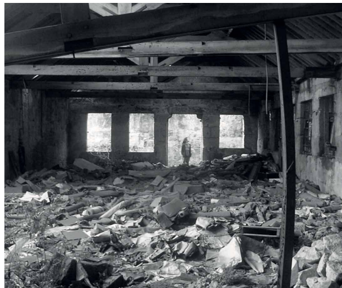
Figura 244 - Interior de pavilhão deteriorado, s.d.
