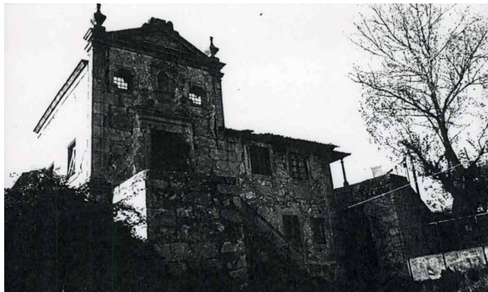
Figuras 111 e 112 - Vistas aproximadas da fachada Sudeste da casa, com as janelas da casa e o pátio de uma das escadarias de acesso ao andar nobre e, do lado direito, da passagem directa do pátio para os quintais. Debaixo desta existia um acesso directo da rua para a capela. Verifica-se também o patamar fronteiriço da capela, que permitia a realização de cerimónias litúrgicas ou sermões orientados para o exterior. Esta tipologia adaptava-se ao costume de se realizarem festas no dia do orago de cada capela ou igreja onde se juntava muita gente, pelo que, nos templos pequenos, as pessoas tinham que ficar no exterior.
