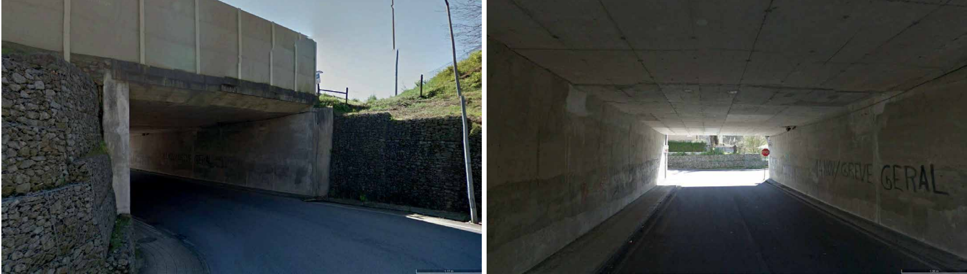
Figuras 719-724 - Vistas do atravessamento em túnel entre Bonjôia e Azevedo, s.d.
