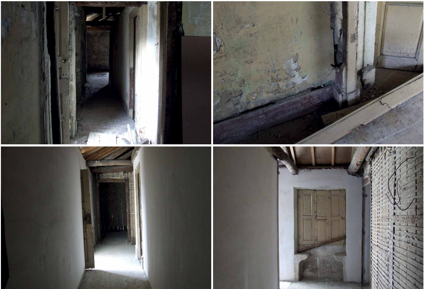
Figuras 576-579 - A partir deste ponto é explorada a parte mais recente da casa. À semelhança do primeiro elemento de canto à entrada, nota-se uma maior riqueza no desenho dos elementos em madeira, designadamente das caixilharias, rodapés e portadas.
