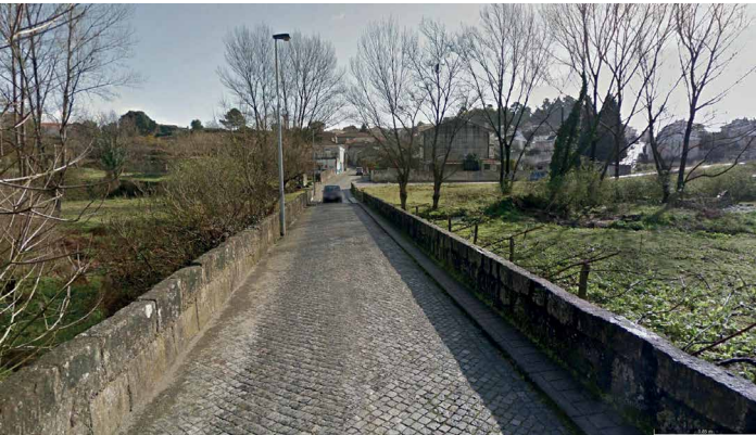
Figura 681 - Vista da Rua Azevedo, 2015
