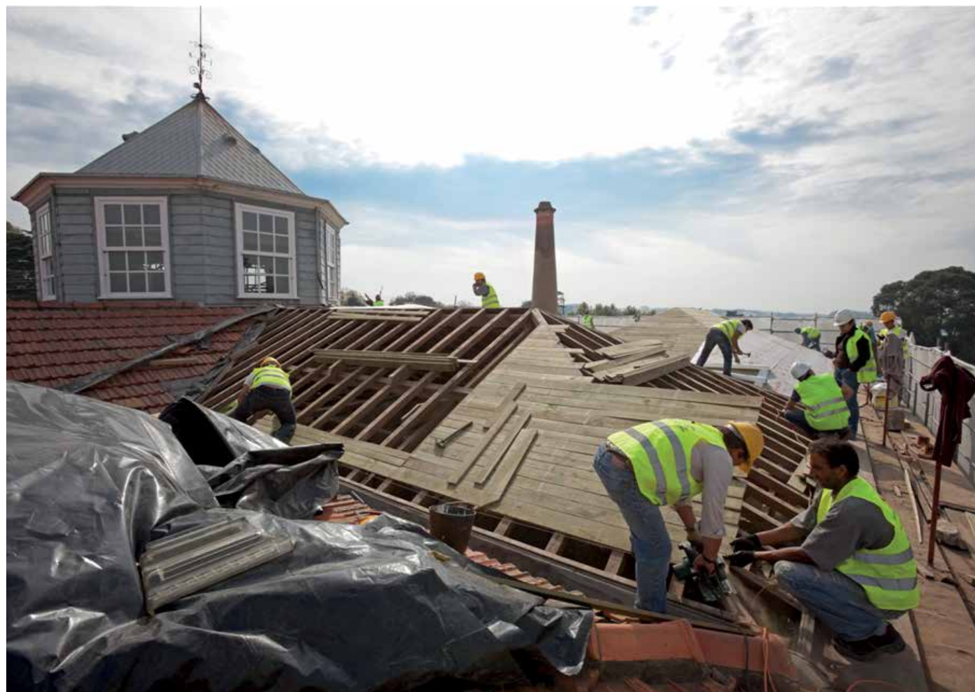
Figura 188 - Colocação da estrutura de madeira da cobertura e respectivo isolamento térmico, Casa Andresen, Porto, 2011
