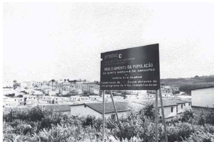
Figura 217 - Início da Construção do bairro da PRODAC, s.d.
