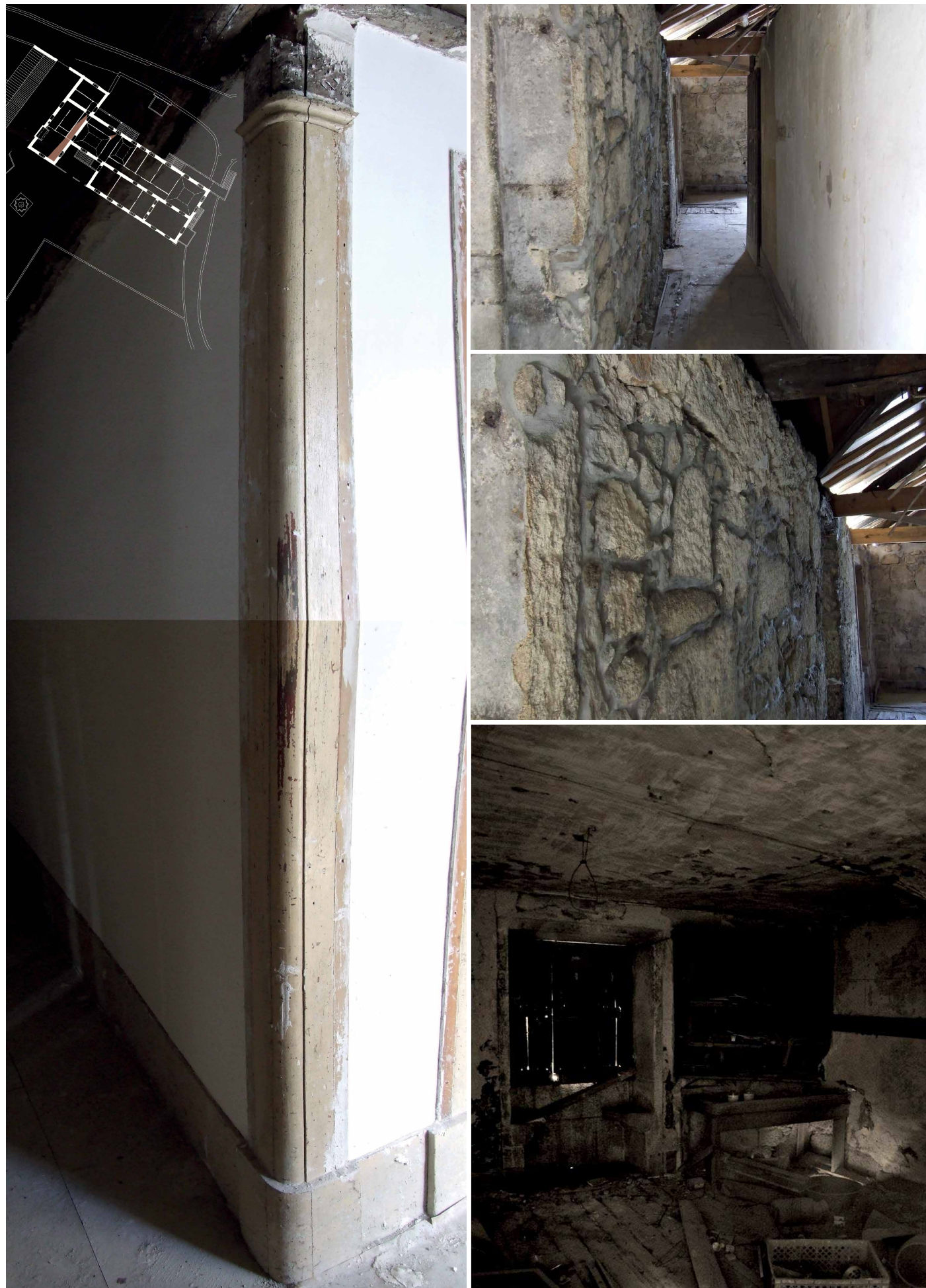
Figuras 557-560 - Após a entrada na casa, observa-se uma guarnição em madeira com um desenho boleado, de remate de uma parede, suavizando uma esquina. Ao dirigir-se para a cozinha, a parede de granito do lado esquerdo contém um vão fechado que remete à existência deste volume como elemento único, sem a parte mais recente, visível por não ter reboco, o que ainda não se verificava em Novembro de 2012, como se pode observar na última figura.
