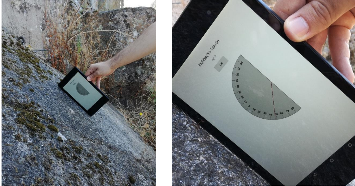
Fig. 66 – Medição da inclinação de um talude rochoso
