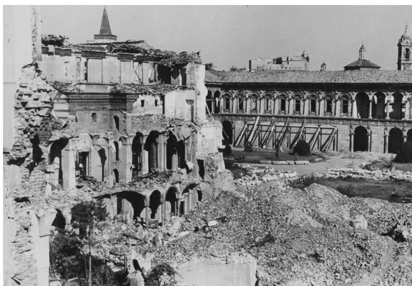
Fig.58 Fotografia do pátio central do Ospedale Maggiore de Milão após os bombardeamentos de 1943.
