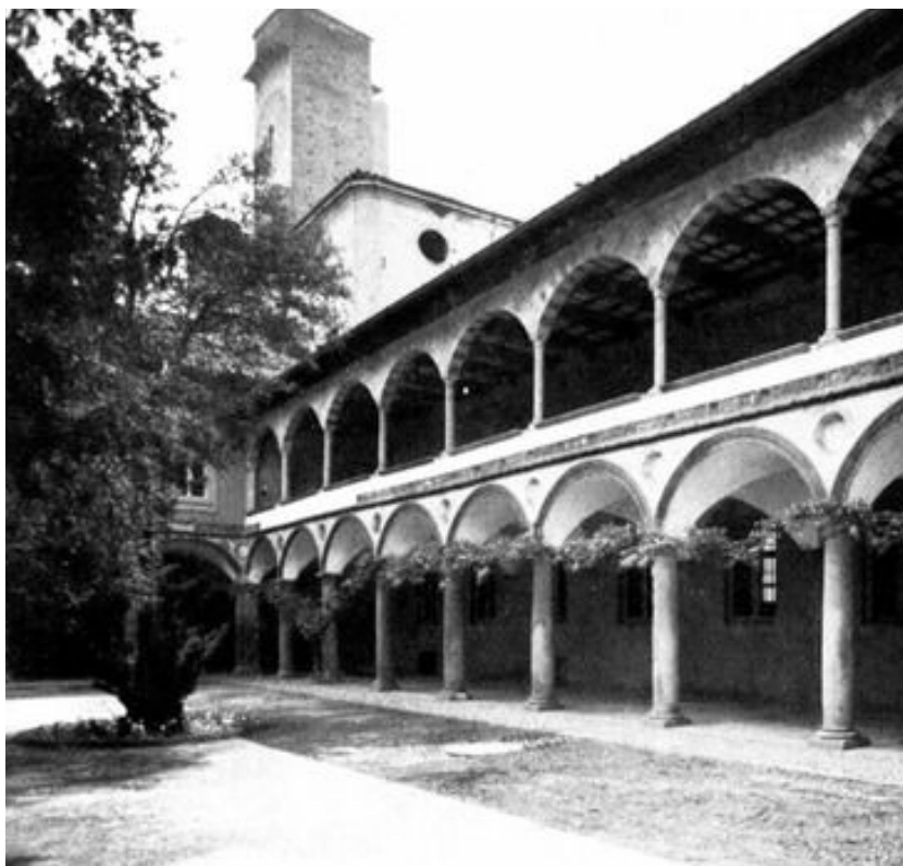
Fig.12 Lado Sul do pátio Sudeste do hospital de San Matteo
