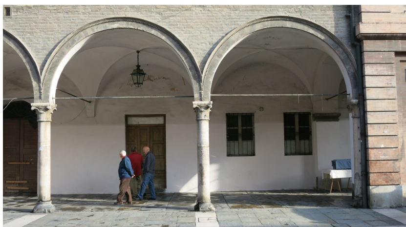
Fig.44 Pormenor da loggia do hospital. A escala do espaço
